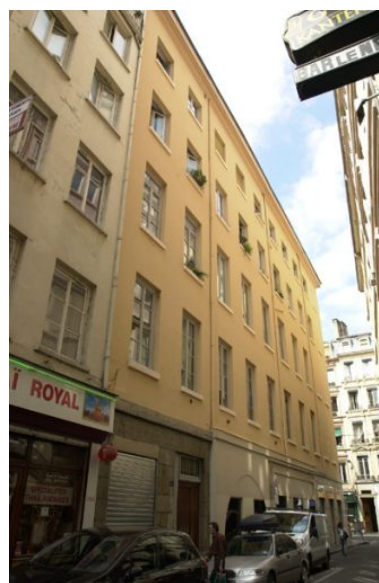
Façade principale rue de la Poulailleterie Phot. Bernard Ducouret IVR82_20046900768NUCA
