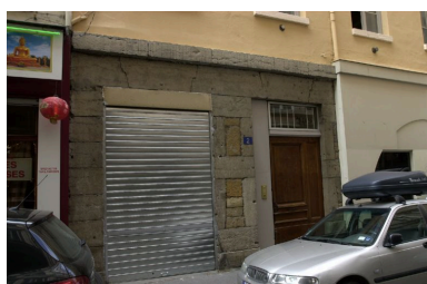
Façade principale rue de la Poulailleterie, partie non transformée du 1er niveau et entrée Phot. Bernard Ducouret IVR82_20046900769NUCA
