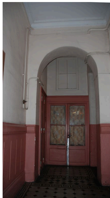
Vue intérieure : entrée de la loge de concierge, au rez-de-chaussée Phot. Catherine Guillot IVR82_20136900055NUCA
