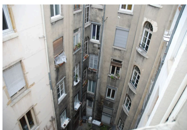
Vue partielle de l'élévation postérieure, occultée à mi-façade par le retour postérieur du 4 rue Béchevelin Phot. Catherine Guillot IVR82_20136900018NUCA
