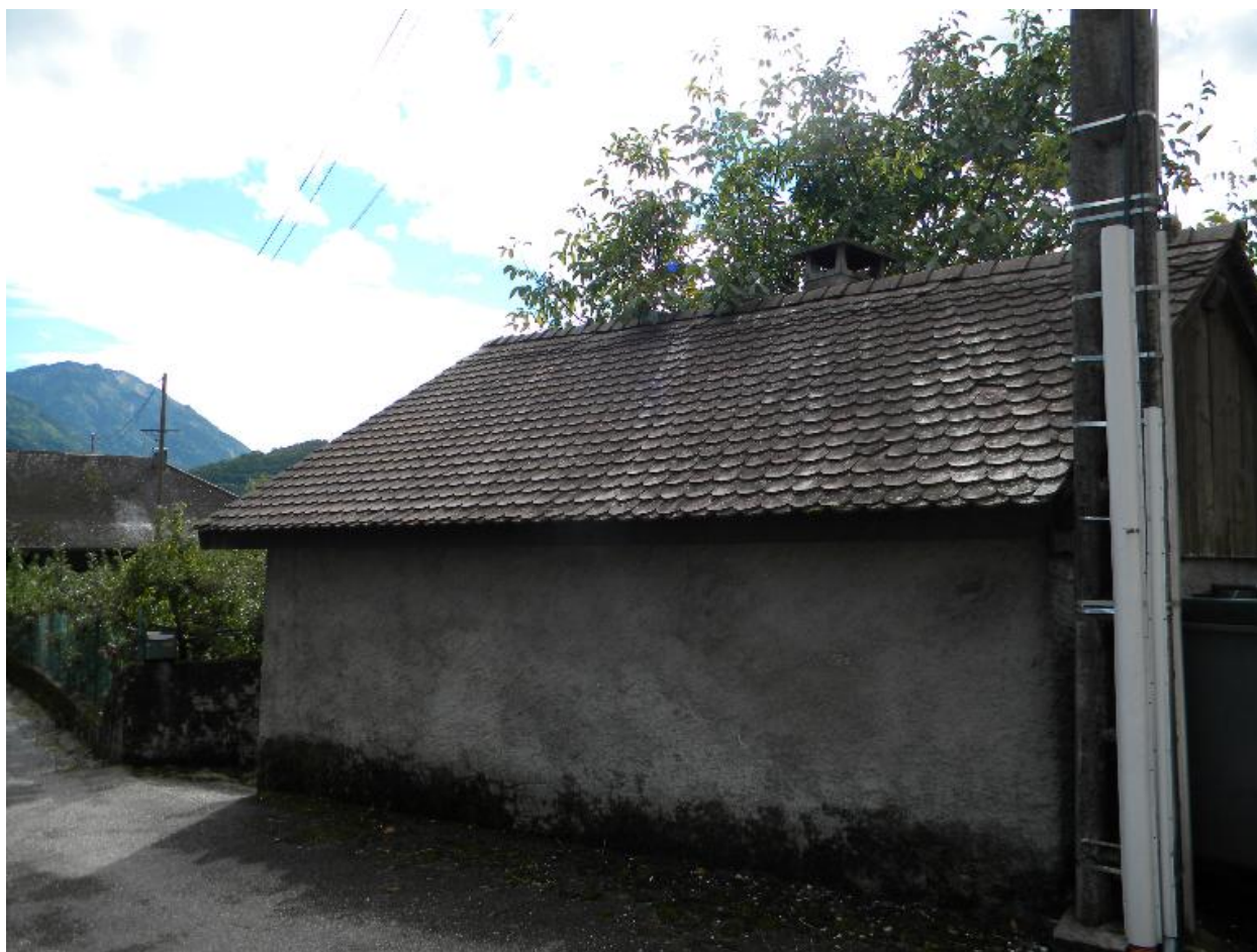
façade nord du four.
