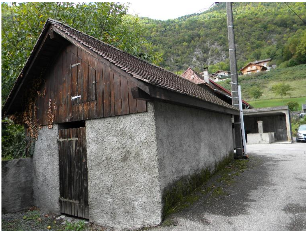
Vue d'ensemble du four.
