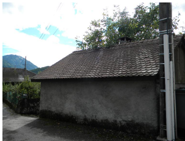
façade nord du four. Phot. Jérôme Daviet IVR82_20137400958NUCA
