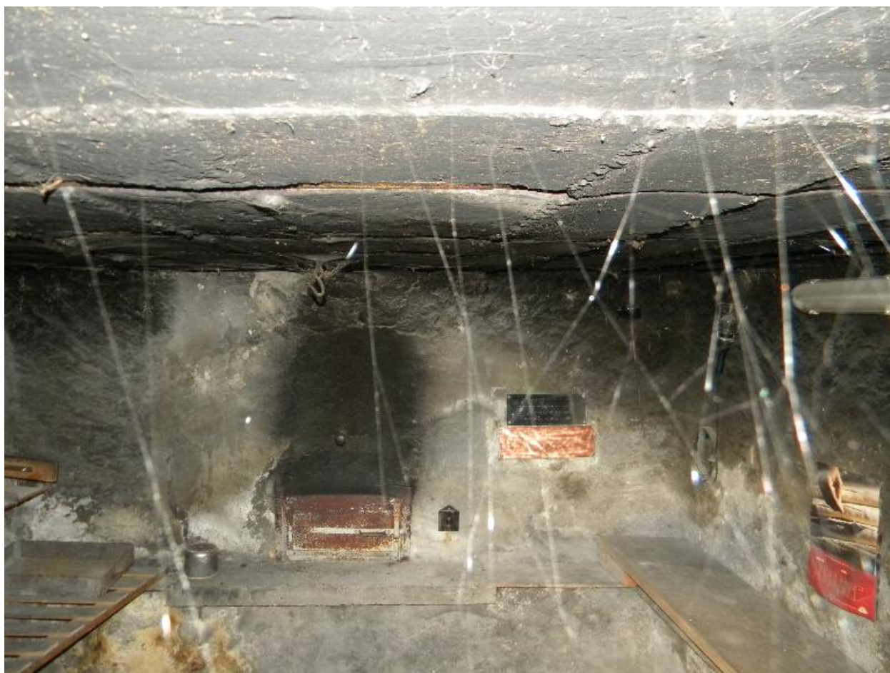
Vue de l'intérieur du four
