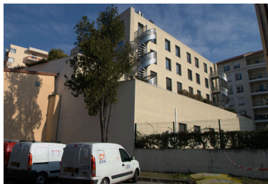
Elévation postérieure depuis le sud-ouest Phot. Maryannick Chalabi IVR82_20136900974NUCA
