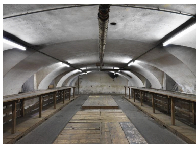
Vue d'ensemble des espaces du sous-sol. Phot. Thierry Leroy IVR82_20136902884NUCAQ
