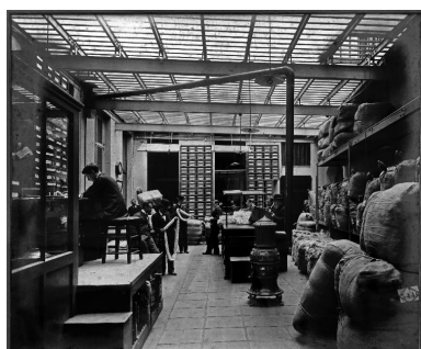
Vue intérieure de la maison de soieries vers 1900 (AP Cie Morel-Journal) Phot. Thierry Leroy IVR82_20136902899NUCB
