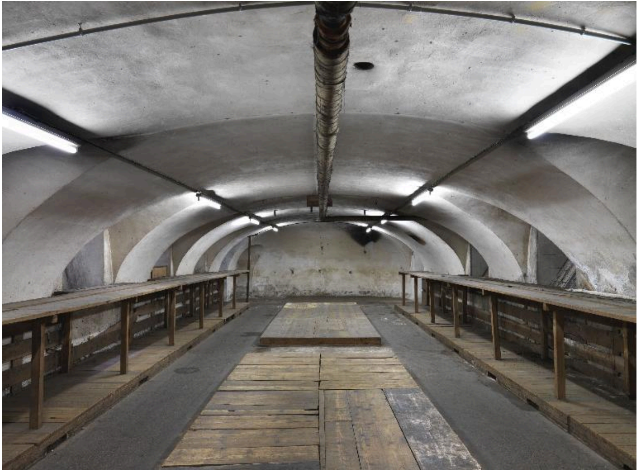
Vue d'ensemble des espaces du sous-sol.
