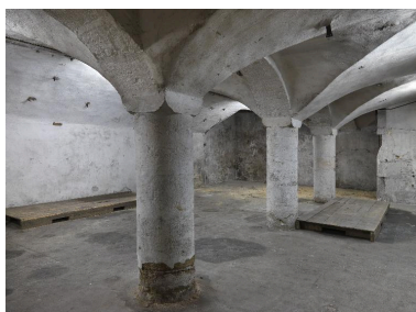
Vue d'ensemble des piliers et voûtes. Phot. Thierry Leroy IVR82_20136902889NUCAQ
