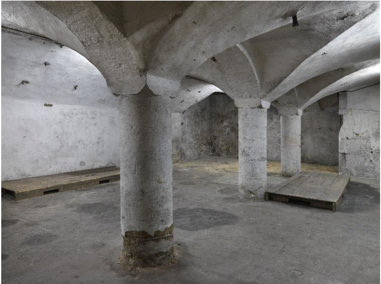
Vue d'ensemble des piliers et voûtes.
