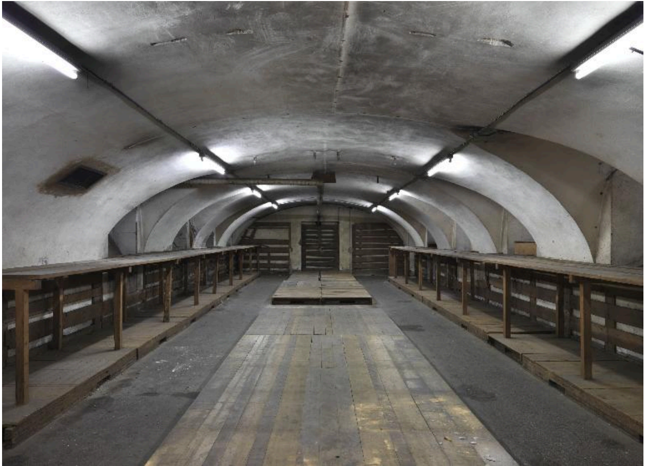
Vue d'ensemble des espaces voûtés.
