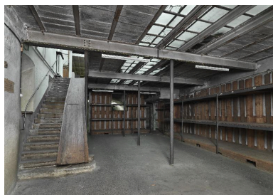
Vue d'ensemble du sous-sol de stockage. Phot. Thierry Leroy IVR82_20136902880NUCAQ
