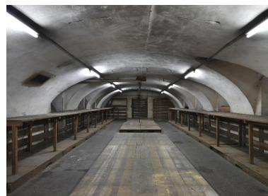
Vue d'ensemble des espaces voûtés. Phot. Thierry Leroy IVR82_20136902883NUCAQ
