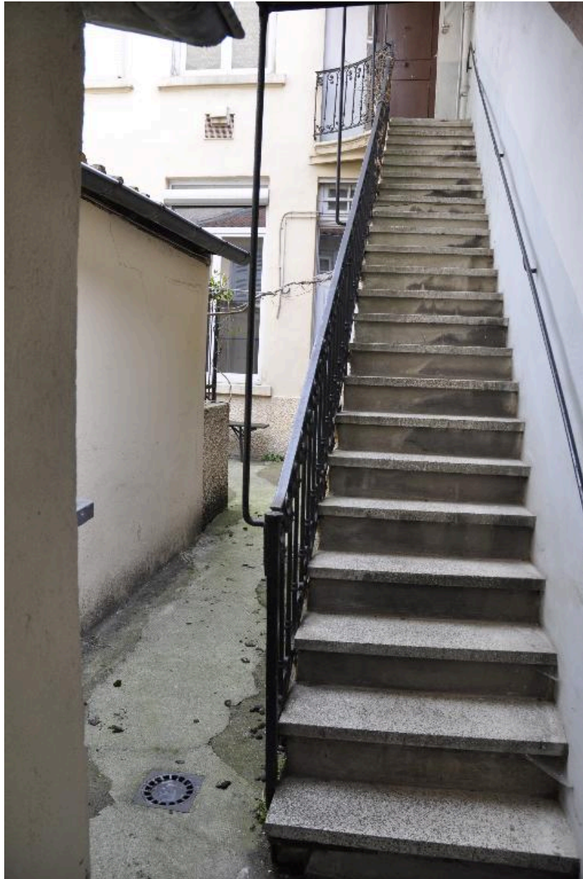
Vue de l'escalier de l'immeuble sur cour
