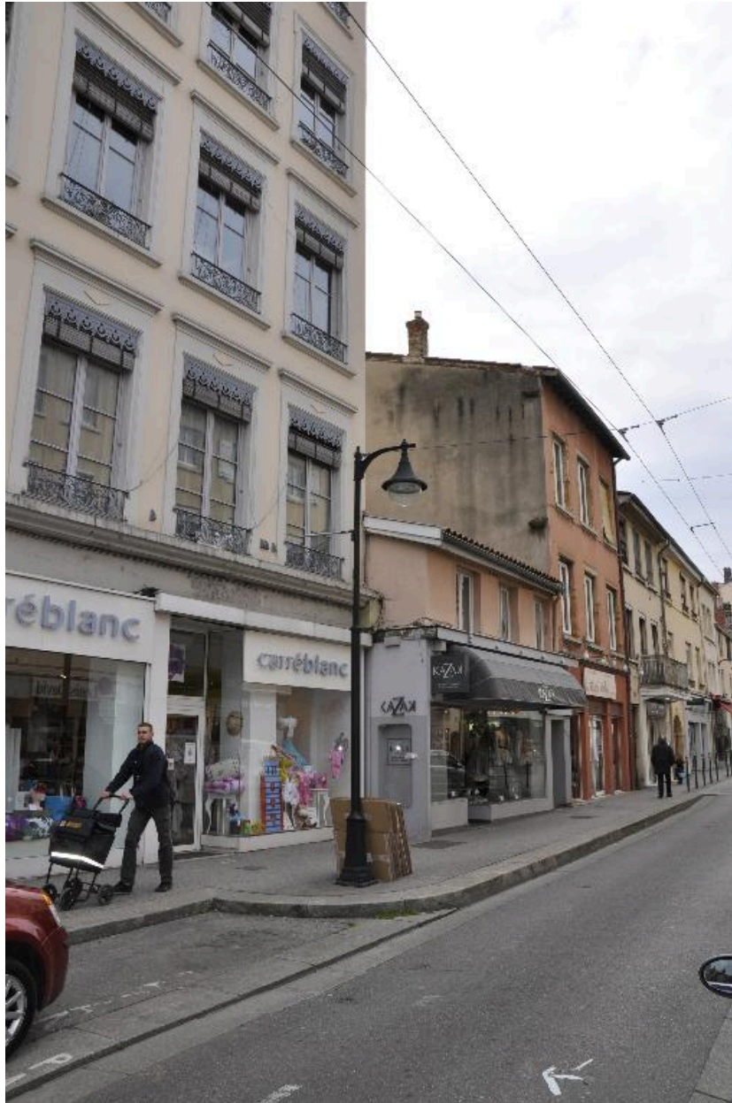
Vue d'ensemble nord ouest de l'immeuble d'un étage
