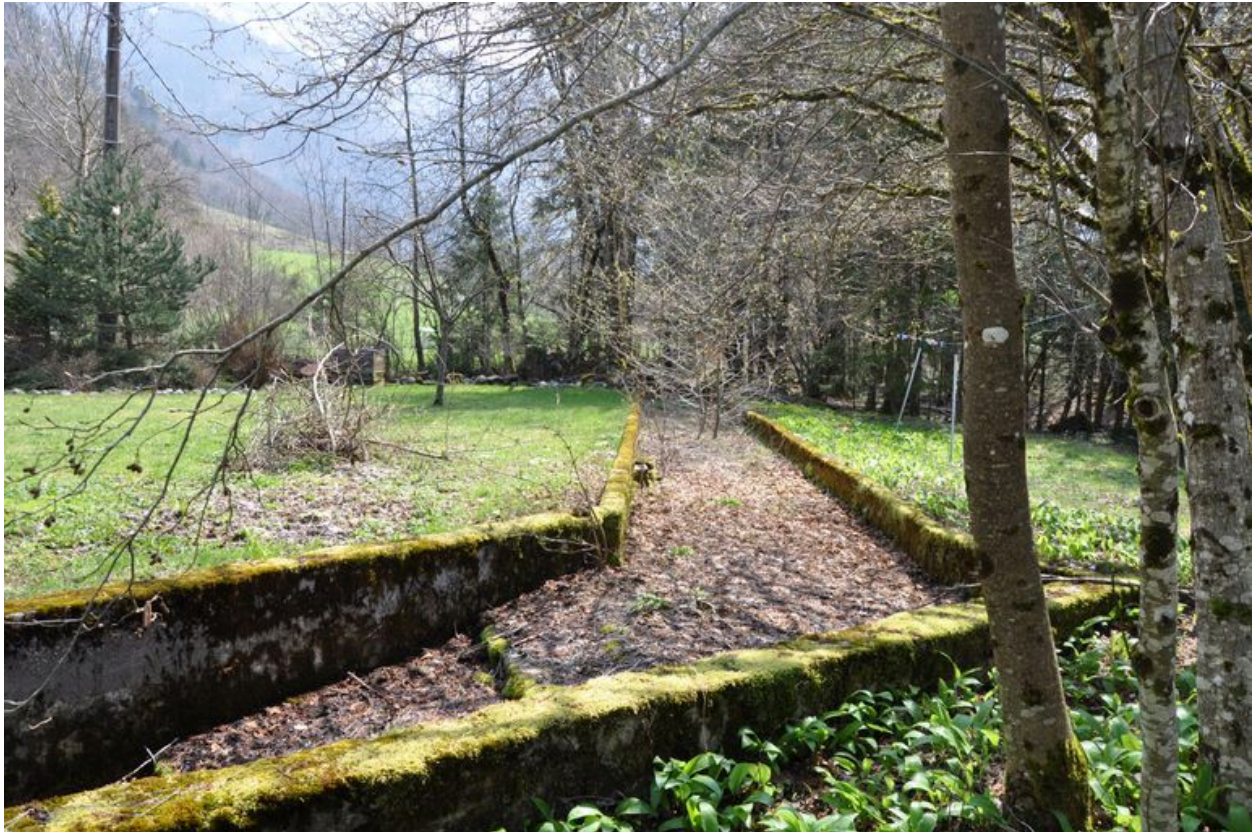
Canal d'amenée du Martinet
