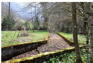
Canal d'amenée du Martinet Phot. Samir Mahfoudi, Autr. Samir Mahfoudi IVR82_20107400200NUCA
