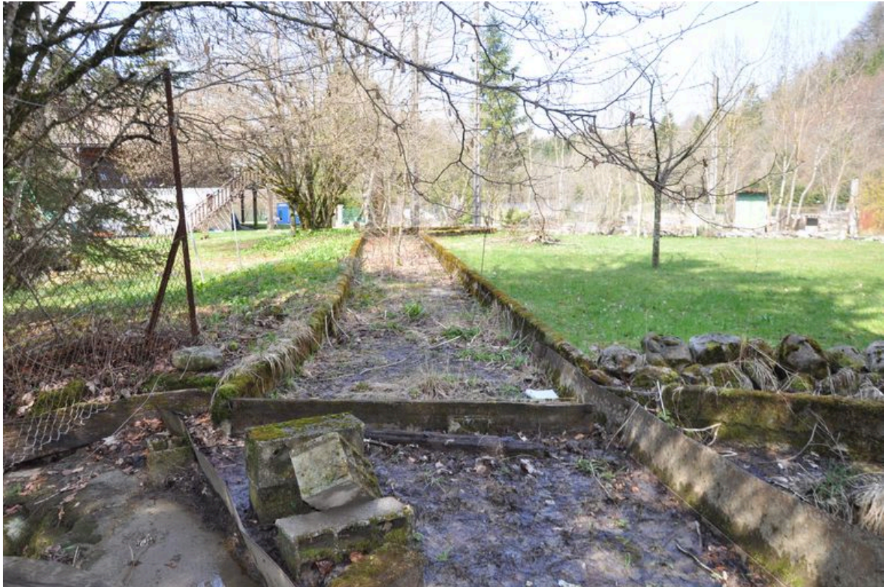
Massifs du canal d'amenée
