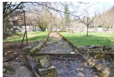
Massifs du canal d'amenée Phot. Samir Mahfoudi, Autr. Samir Mahfoudi IVR82_20107400199NUCA
