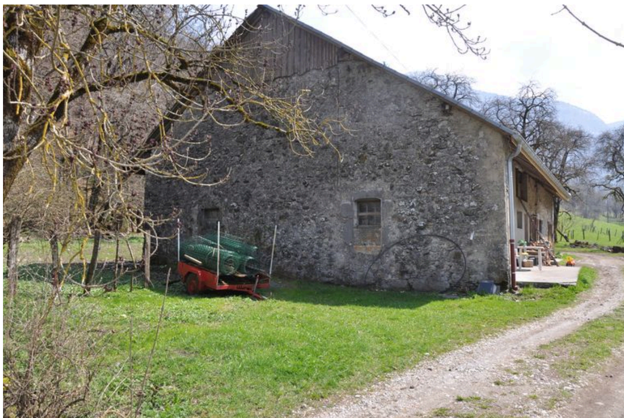
Mur Pigon ouest de l'ancien bâtiment du martinet
