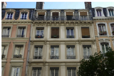
Façade, partie supérieure Phot. Bernard Ducouret IVR82_20046900978NUCA
