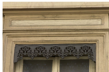
Façade, 3e niveau, détail du lambrequin de la 2e fenêtre Phot. Bernard Ducouret IVR82_20046900979NUCA
