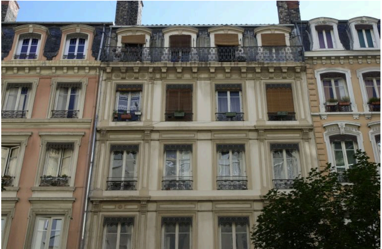
Façade, partie supérieure
