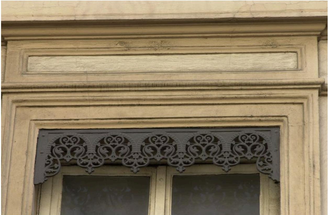
Façade, 3e niveau, détail du lambrequin de la 2e fenêtre
