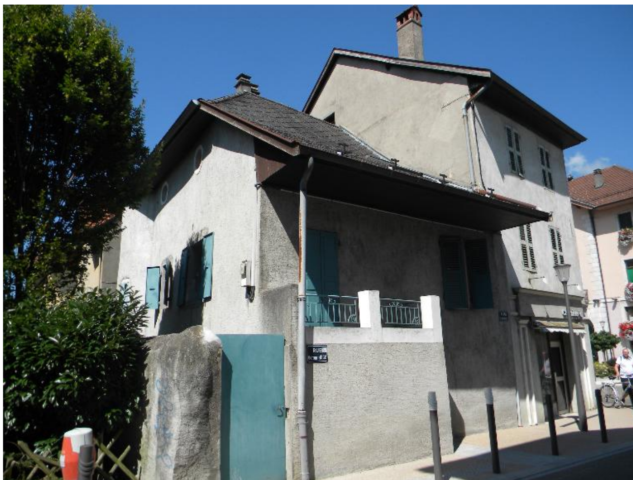
Vue d'ensemble du bâtiment
