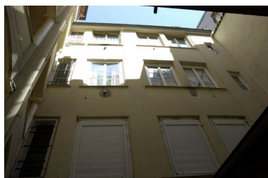
2e corps de logis, façade sur cour Phot. Bernard Ducouret IVR82_20036901205NUCA
