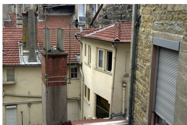
Pavillon d'escalier, élévation, vue latérale de la partie supérieure Phot. Bernard Ducouret IVR82_20036901192NUCA
