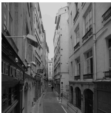
Façade sur rue Phot. Eric Dessert IVR82_20056900406NUC
