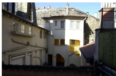
Pavillon d'escalier, élévation, détail de la partie supérieure Phot. Bernard Ducouret IVR82_20036901267NUCA
