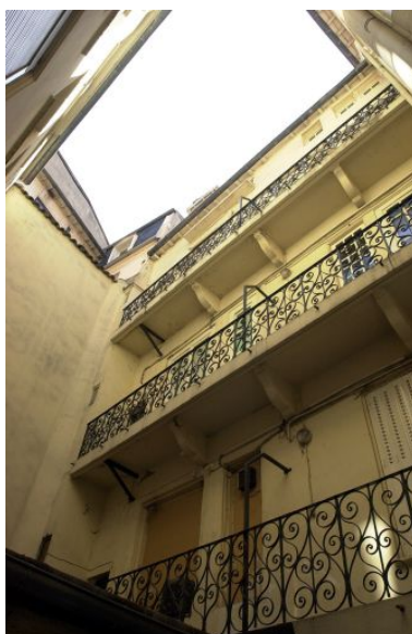
1er corps de logis, façade sur cour, partie gauche Phot. Bernard Ducouret IVR82_20036901207NUCA
