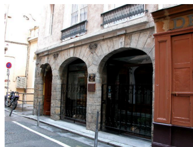
Façade sur rue, rez-de-chaussée Phot. Bernard Ducouret IVR82_20036901266NUCA
