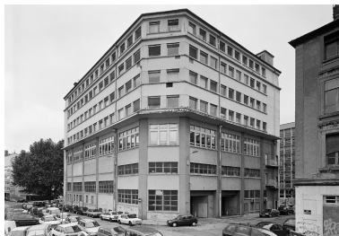
Vue sud-ouest Phot. Didier Gourbin IVR82_20026904444P
