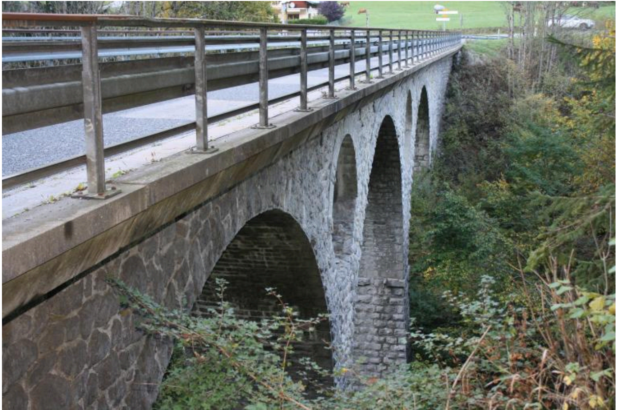
Pont de la Tassonnière, face amont
