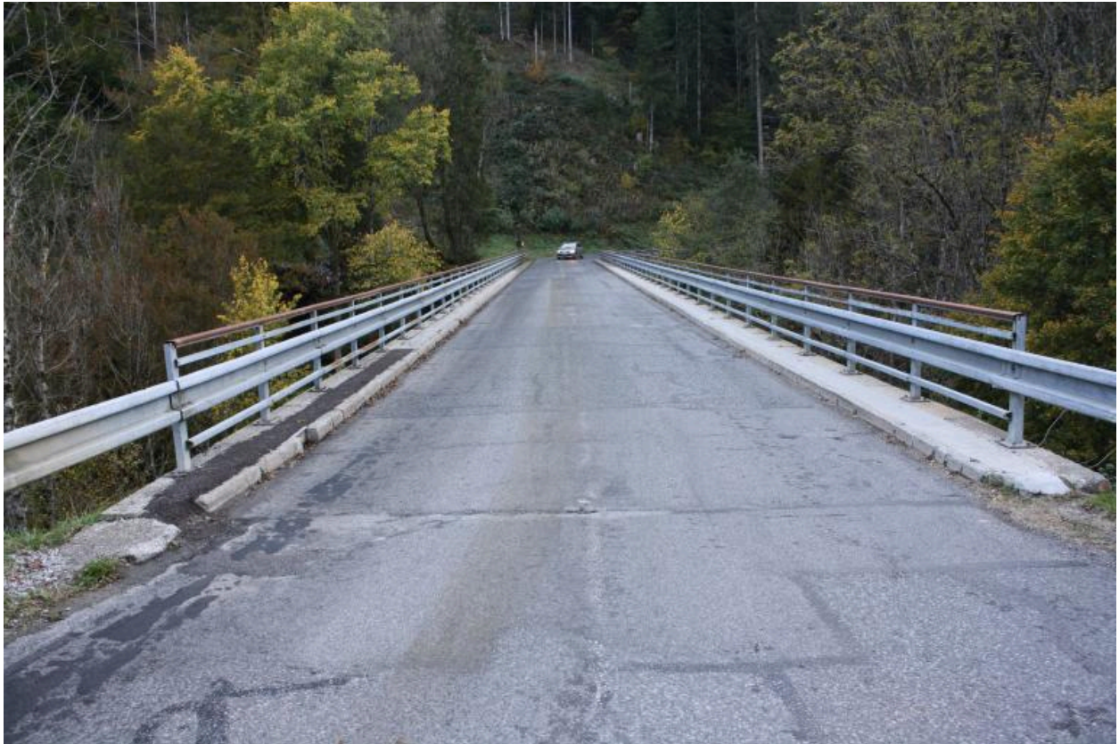
Pont de la Tassonnière, chaussée et gardes corps
