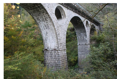
Pont de la Tassonnière, face aval Phot. Benoît Huraut IVR84_20207401251NUCA
