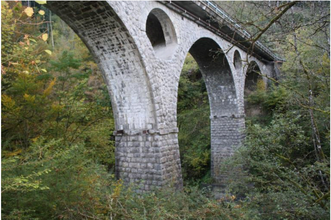
Pont de la Tassonnière, face aval
