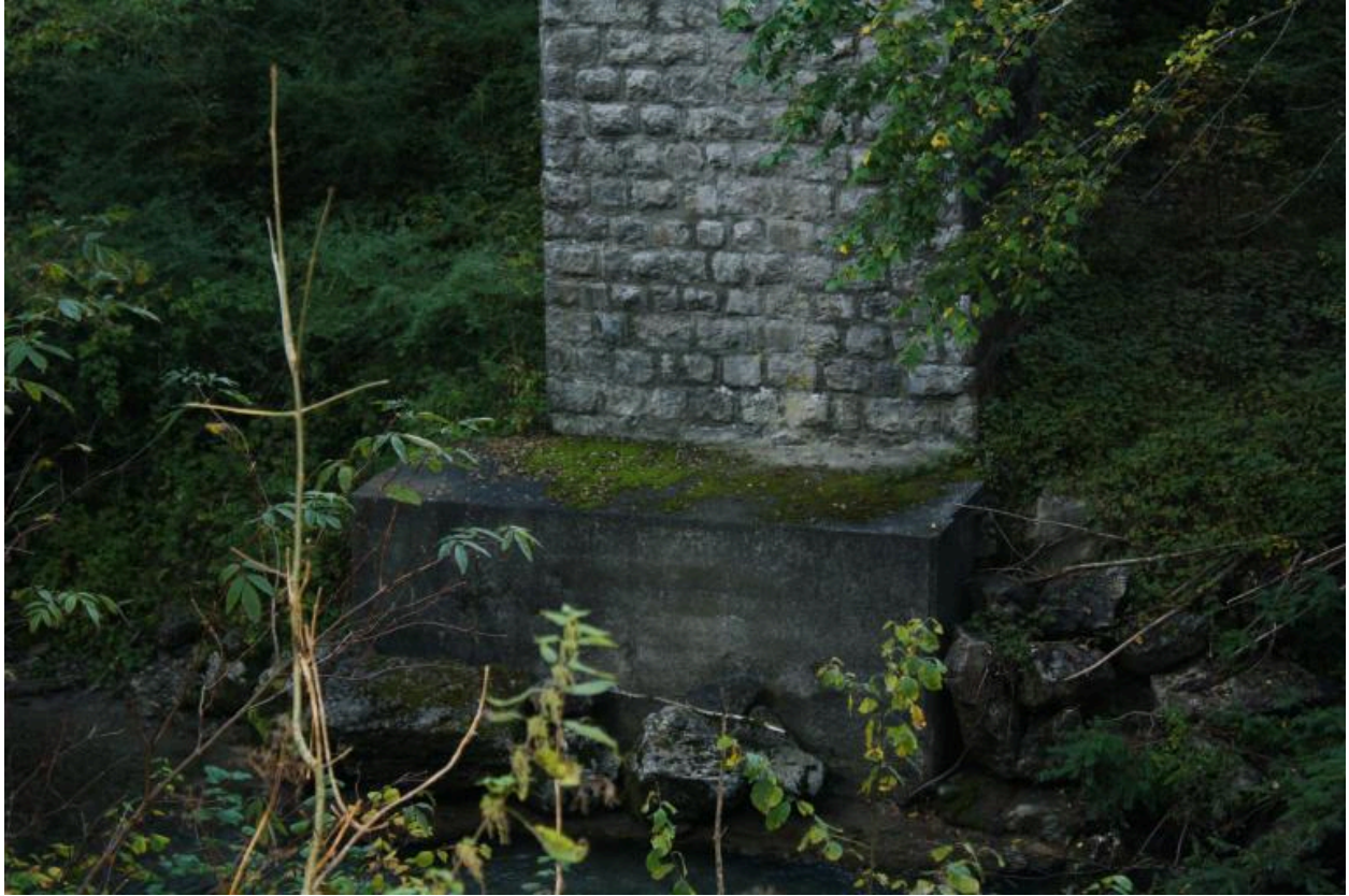
Pont de la Tassonnière, pile et socle
