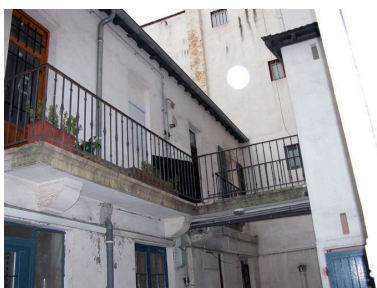
Vue de la coursière distribuant l'étage Phot. N. Giroud IVR82_20046904120NUCA
