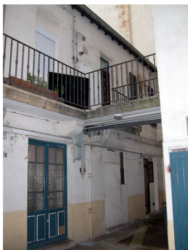
Partie centrale de l'élévation Phot. N. Giroud IVR82_20046904119NUCA
