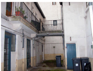
Vue générale de l'élévation et de la passerelle reliant l'escalier de l'immeuble sur rue à la coursière Phot. N. Giroud IVR82_20046904121NUCA
