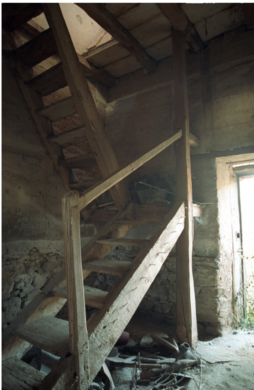
Vue intérieure du rez-de-chaussée.
