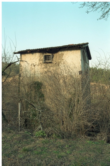
Vue d'ensemble. Phot. Thierry Monnet IVR82_20034200969ZE
