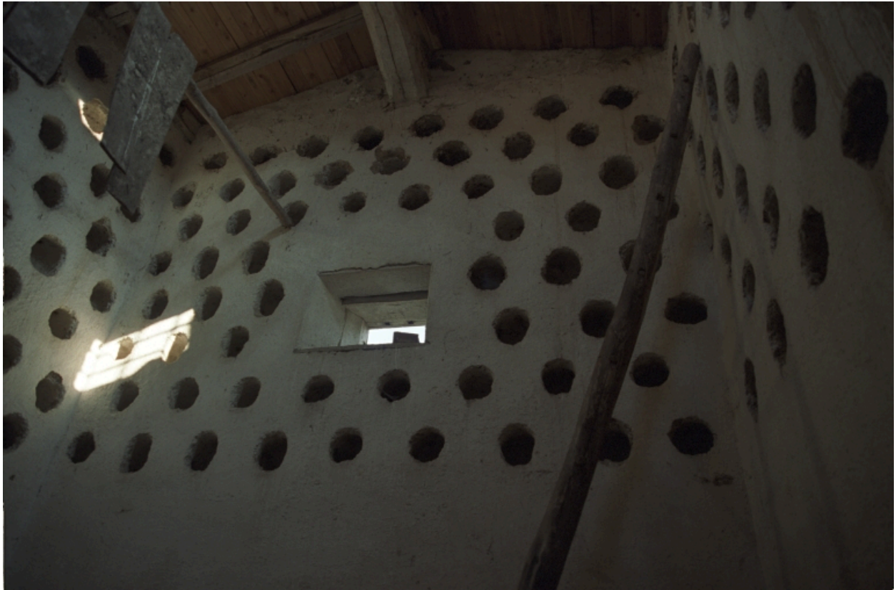
Vue intérieure de l'étage : trous de boulin, fenêtre de sortie.
