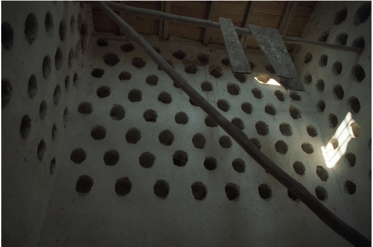
Vue intérieure de l'étage : trous de boulin.
