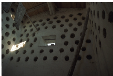
Vue intérieure de l'étage : trous de boulin, fenêtre de sortie. Phot. Thierry Monnet IVR82_20034200973ZE
