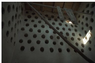
Vue intérieure de l'étage : trous de boulin. Phot. Thierry Monnet IVR82_20034200972ZE
