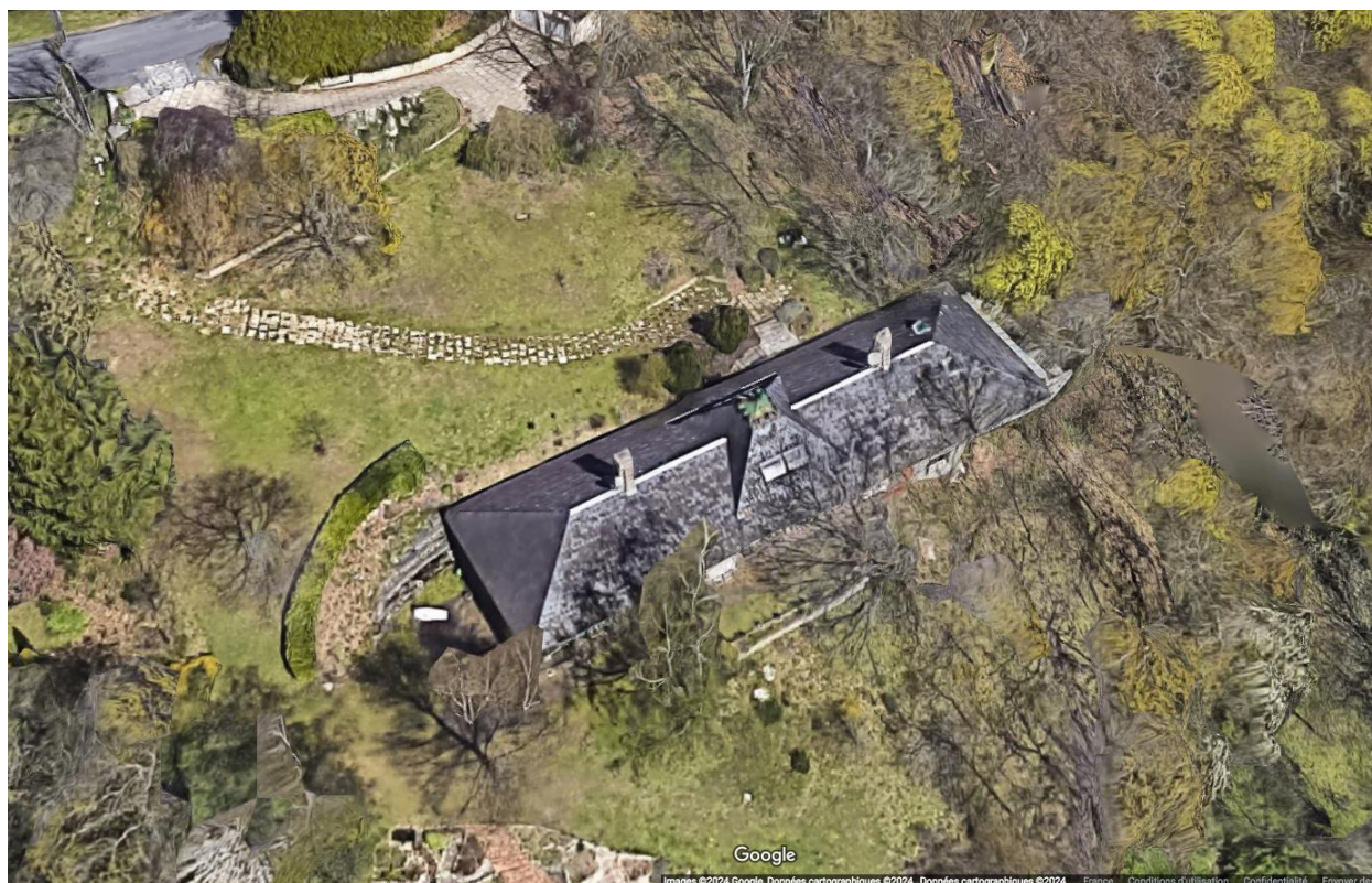
Orcines, la maison Br., vue aérienne Google.
