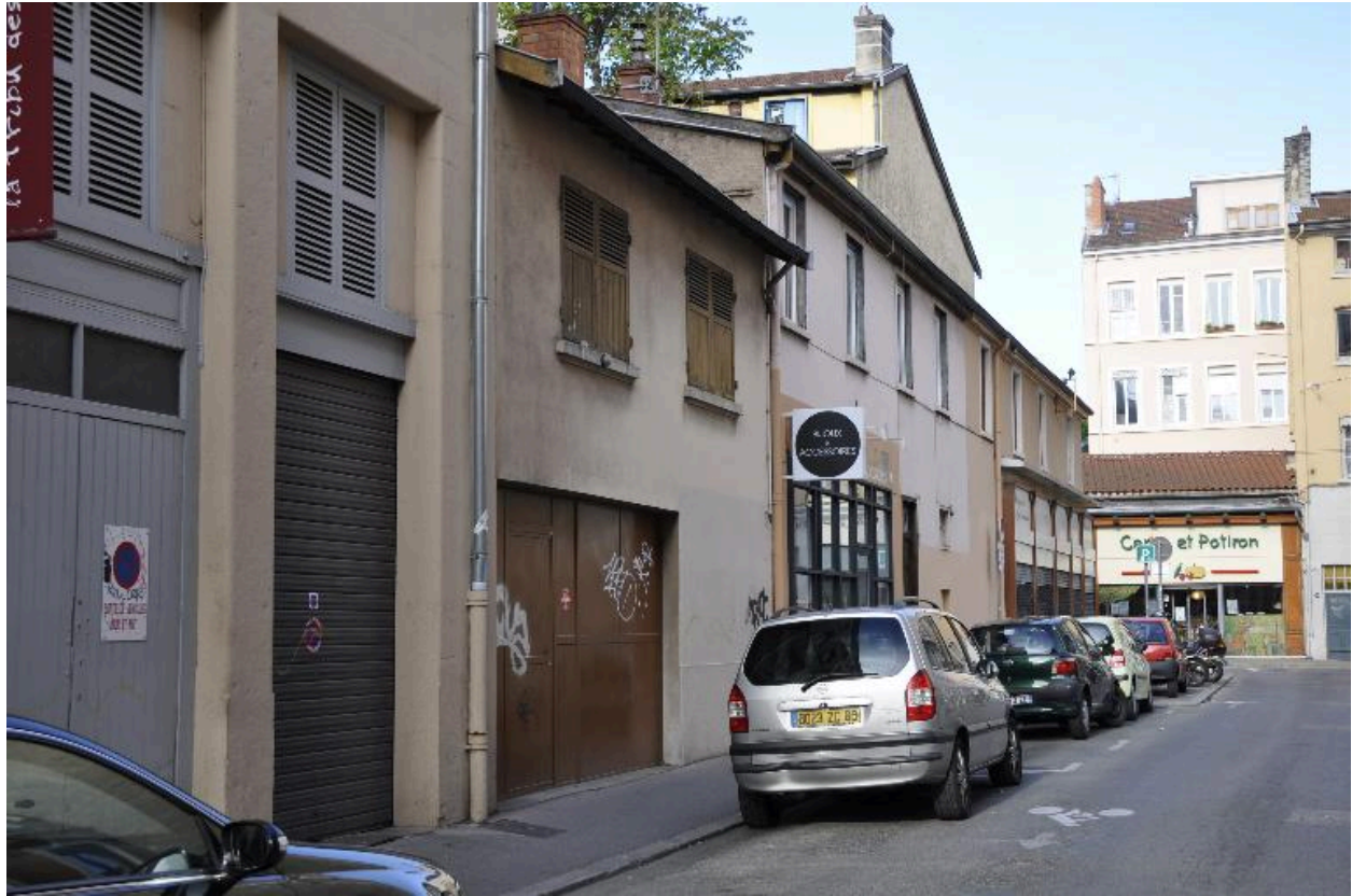
Vue d'ensemble nord est
