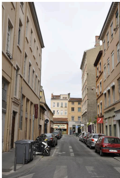
Vue d'ensemble est de la rue d'Ivry Phot. Nadine Halitim-Dubois IVR82_20146900563NUCA
