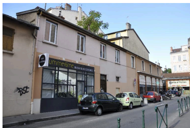
Vue nord est du deuxième corps de bâtiment Phot. Nadine Halitim-Dubois IVR82_20146900468NUCA
