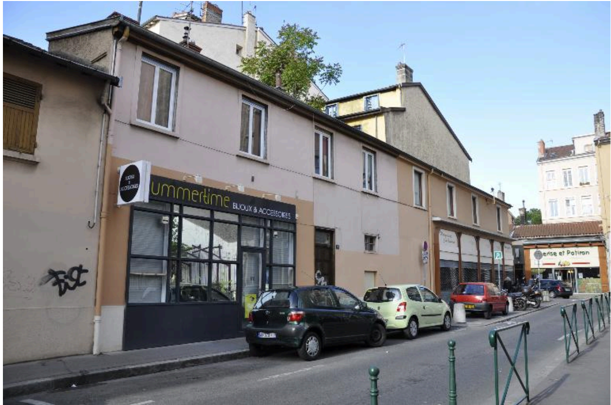
Vue nord est du deuxième corps de bâtiment
