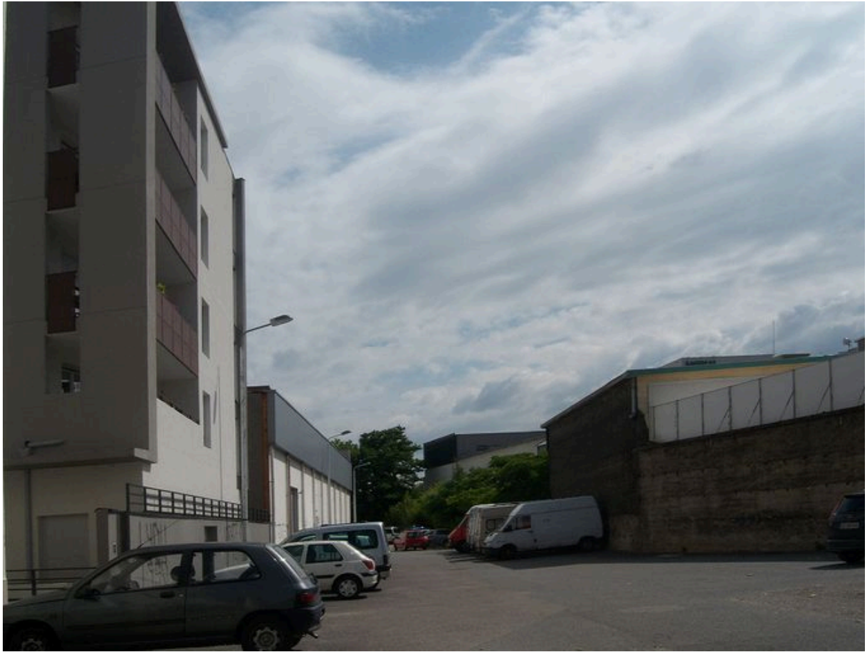
Vue sur l'élévation postérieure, rue Prosper Chappet
