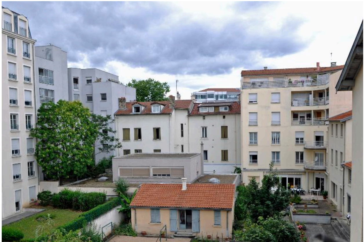
Vue générale, depuis l'est : élévations sur cour et toiture de l'atelier
