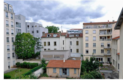
Vue générale, depuis l'est : élévations sur cour et toiture de l'atelier Phot. Magali Delavenne IVR84_20176901440NUCA
