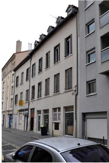
Vue d'ensemble prise depuis le sud-ouest Phot. Magali Delavenne IVR84_20176901439NUCA
