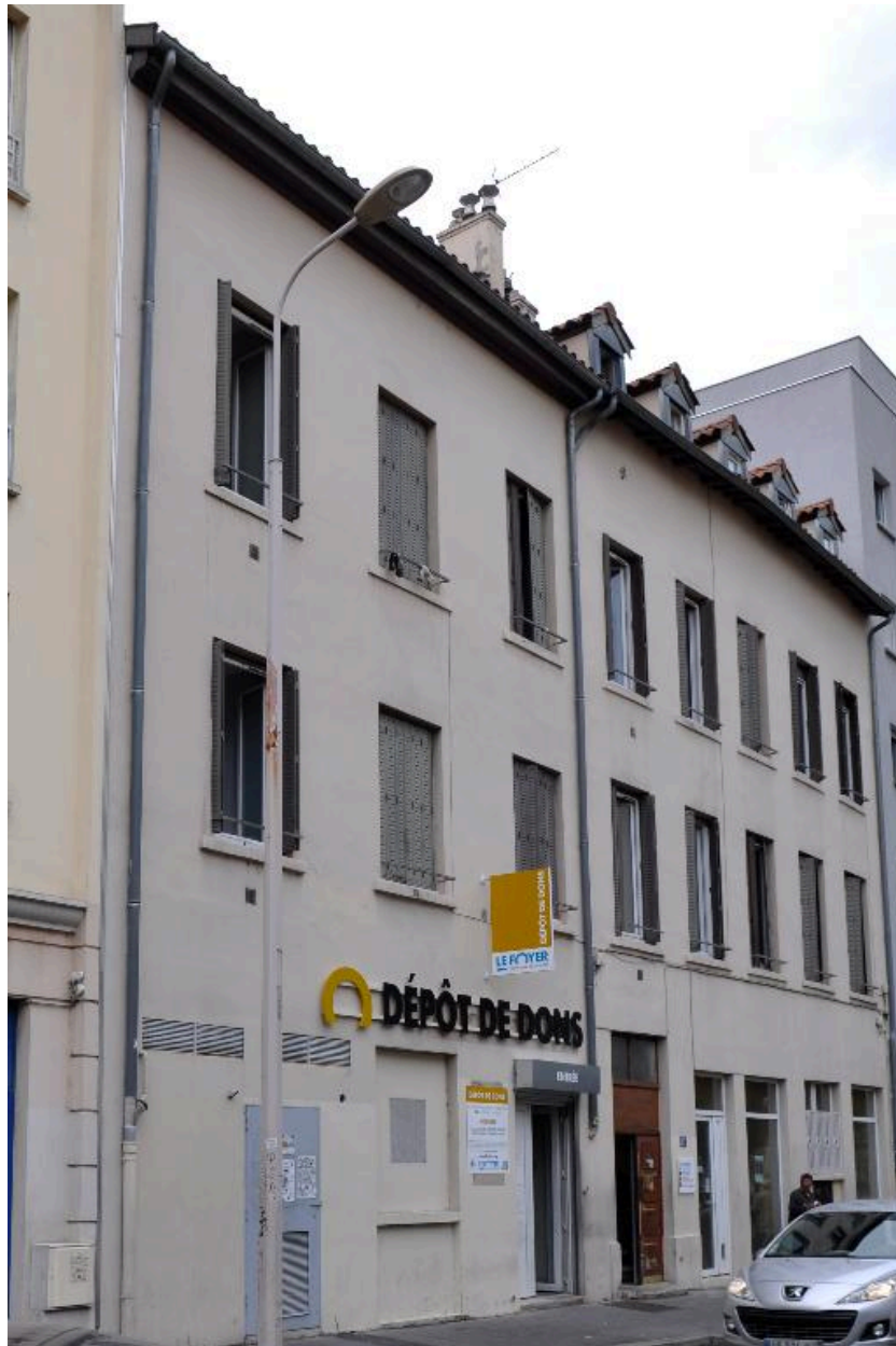
Vue d'ensemble, prise depuis le nord-ouest
