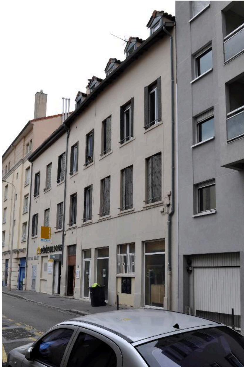
Vue d'ensemble prise depuis le sud-ouest
