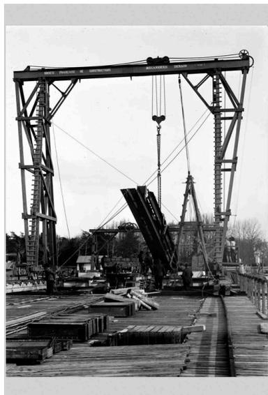
La construction du pont de la Boucle. la pose des poutrelles des arches supérieures. Photogr., [1903] (Arch. mun. Lyon. 15 Ph 1817) IVR82\_20106901082NUCB
