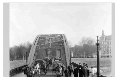
La construction du pont de la Boucle. L'épreuve de charge. Photogr., [1903] (Arch. mun. Lyon. 15 Ph 1836) IVR82\_20106901096NUCB
