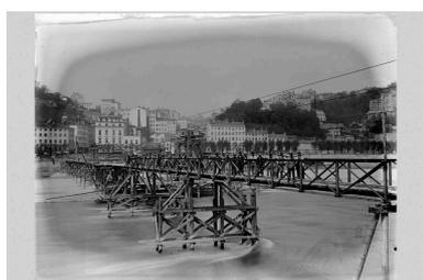
La construction du pont de la Boucle. Charpente de soutien des premiers
