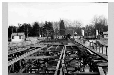
La construction du pont de la Boucle. Les structures métalliques du tablier. Photogr., [1902]
