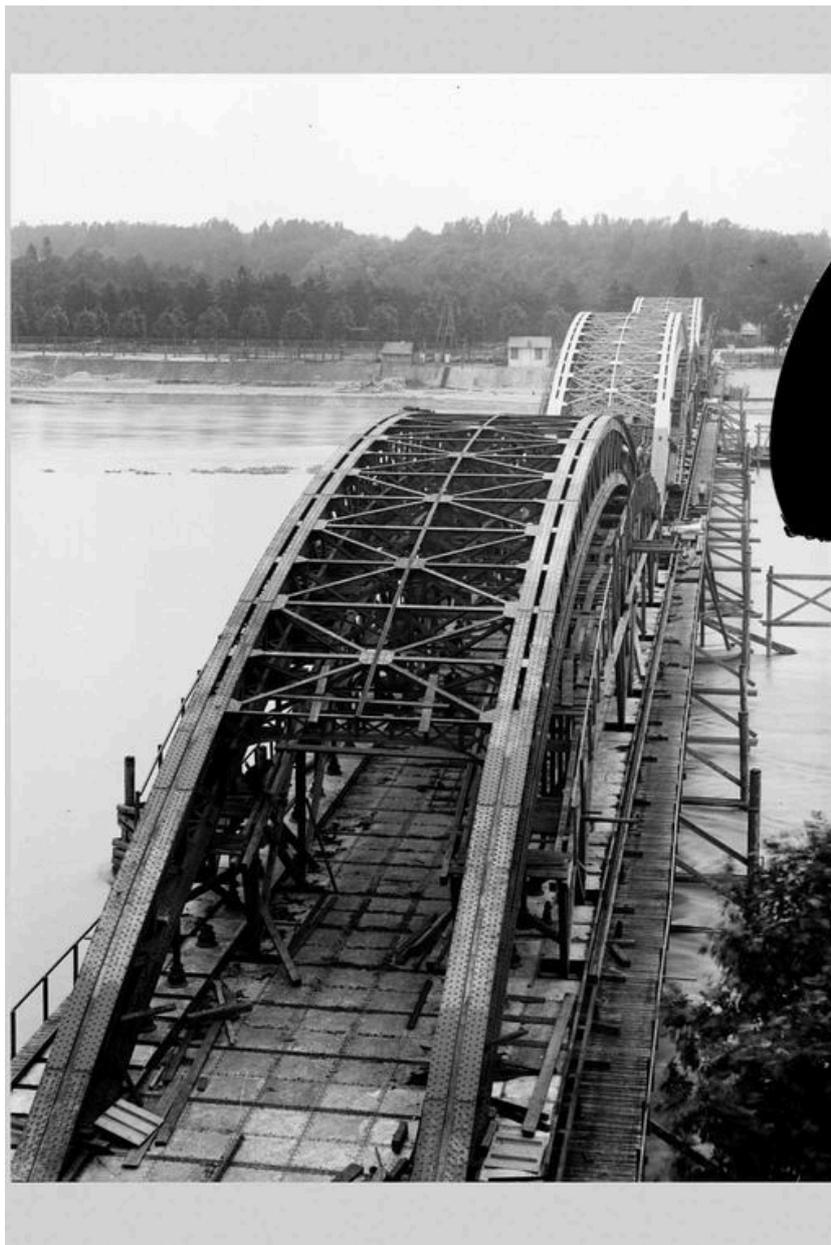
La construction du pont de la Boucle. La dernière arche en voie d'achèvement. Photograph., [1903] (Arch. mun. Lyon. 15 Ph 1834)
