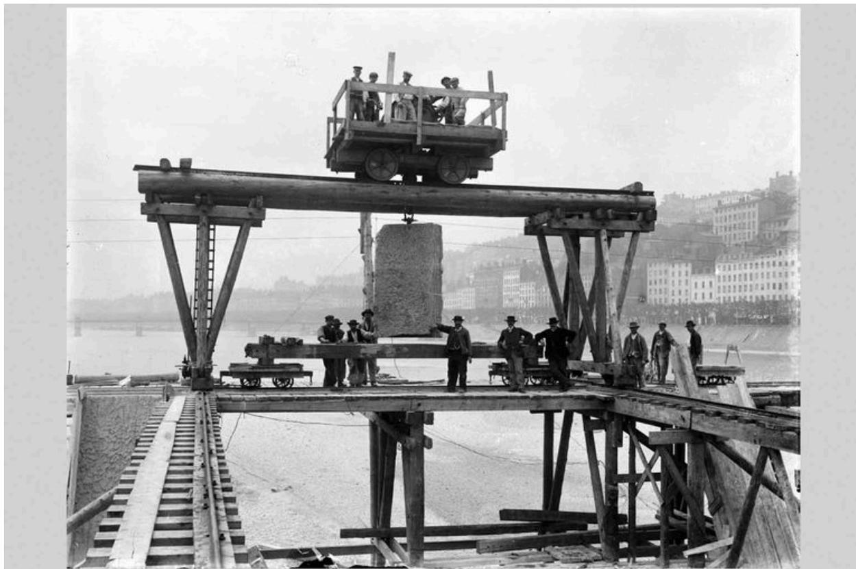
La construction du pont de la Boucle. La pose des maçonneries des piles. Photogr., [1902] (Arch. mun. Lyon. 15 Ph 1797)
