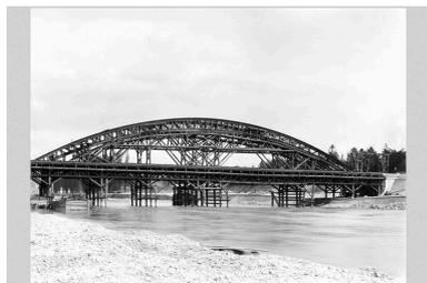
La construction du pont de la Boucle. La 1ère arche supérieure. Photogr., [1903] (Arch. mun. Lyon. 15 Ph 1825) IVR82\_20106901088NUCB
