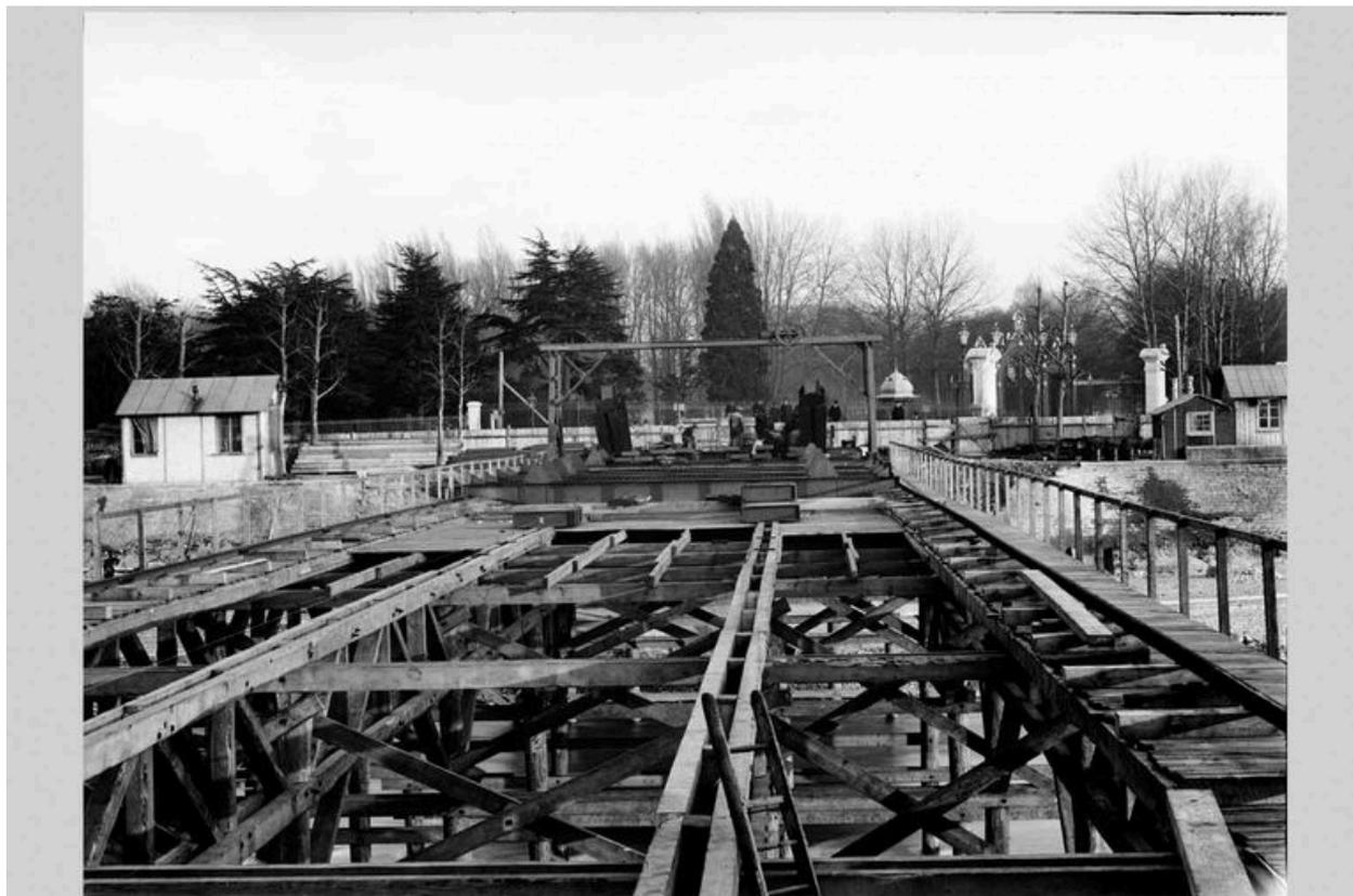
La construction du pont de la Boucle. Les structures métalliques du tablier. Photogr., [1902] (Arch. mun. Lyon. 15 Ph 1808)
