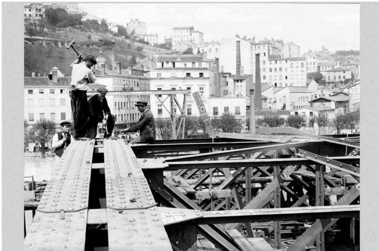
La construction du pont de la Boucle. La construction des arches supérieures. Photogr., [1903] (Arch. mun. Lyon. 15 Ph 1827)
