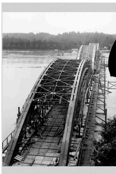
La construction du pont de la Boucle. La dernière arche en voie d'achèvement. Photogr., [1903] (Arch. mun. Lyon. 15 Ph 1834) IVR82\_20106901095NUCB
