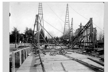
La construction du pont de la Boucle. La pose du tablier. Photogr., [1902]
