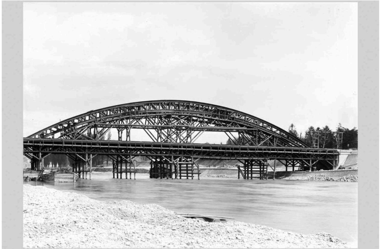
La construction du pont de la Boucle. La 1ère arche supérieure. Photograph., [1903] (Arch. mun. Lyon. 15 Ph 1825)
