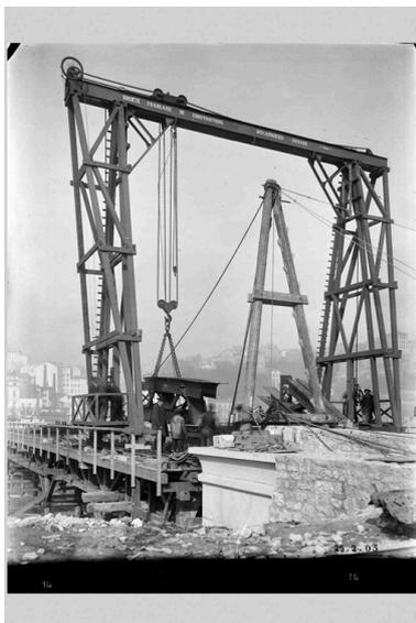
La construction du pont de la Boucle. La pose des poutrelles. Photogr., 25 février 1903
