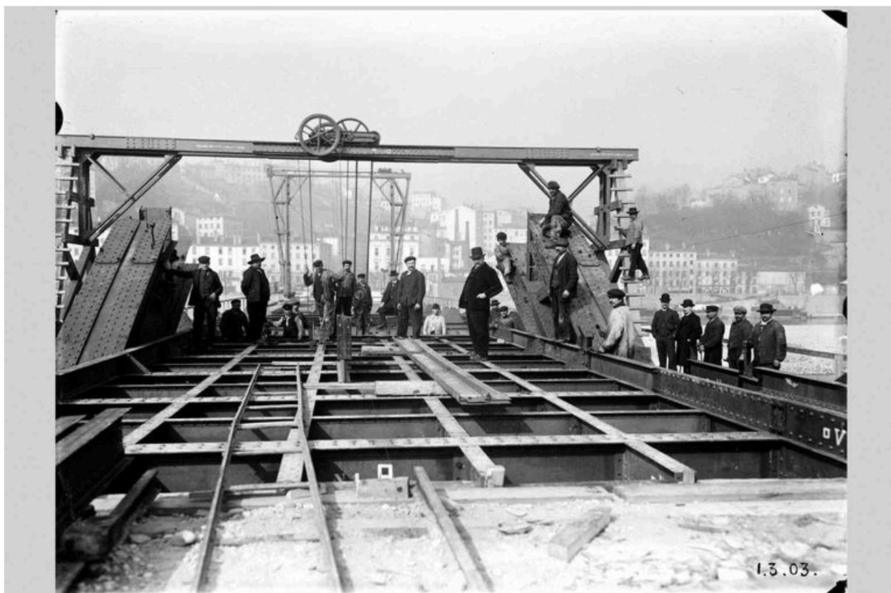
La construction du pont de la Boucle. Réunion de chantier, après la pose du tablier. Photogr., 1er mars 1903 (Arch. mun. Lyon. 15 Ph 1813)
