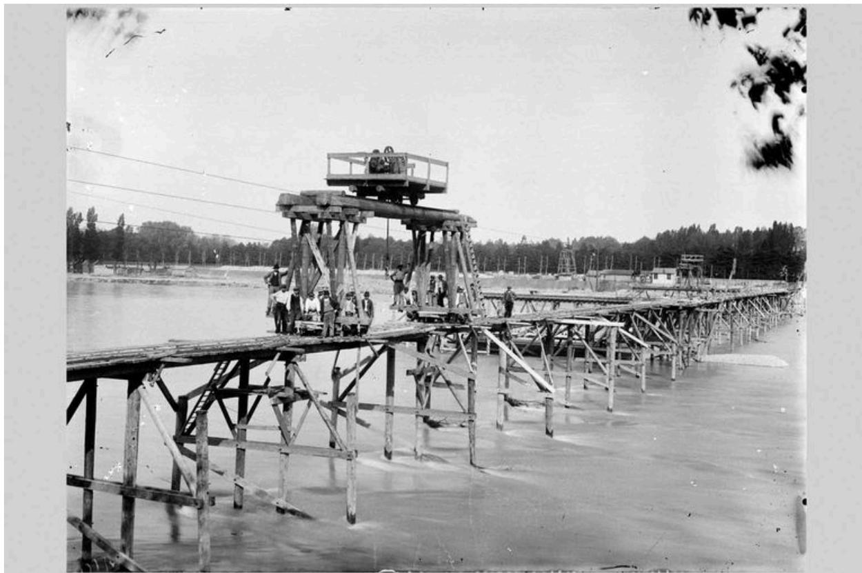
La construction du pont de la Boucle. La pose des maçonnerie des piles. Photogr., [1902] (Arch. mun. Lyon. 15 Ph 1800)
