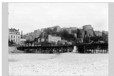
La construction du pont de la Boucle. Vue d'ensemble du tablier et des pieux le soutenant. Photogr., [1903] (Arch. mun. Lyon. 15 Ph 1821) IVR82\_20106901085NUCB
