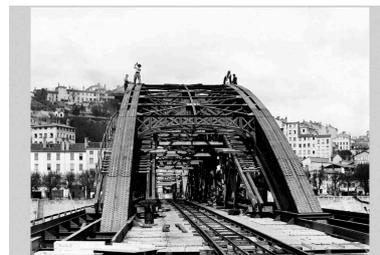
La construction du pont de la Boucle. La construction des arches supérieures. Photogr., [1903] (Arch. mun. Lyon. 15 Ph 1826) IVR82\_20106901090NUCB
