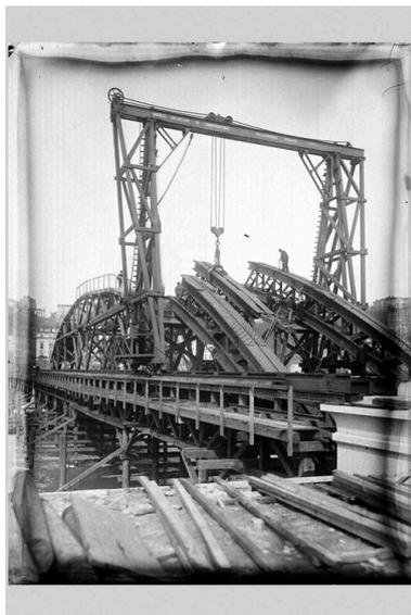
La construction du pont de la Boucle. La pose des poutrelles des arches supérieures. Photogr., [1903] (Arch. mun. Lyon. 15 Ph 1818) IVR82\_20106901083NUCB
