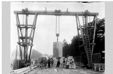
La construction du pont de la Boucle. La pose des maçonneries des piles. Photogr., [1902]
