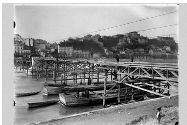
La construction du pont de la Boucle. Les premières structures du tablier. Photogr., [1902]
