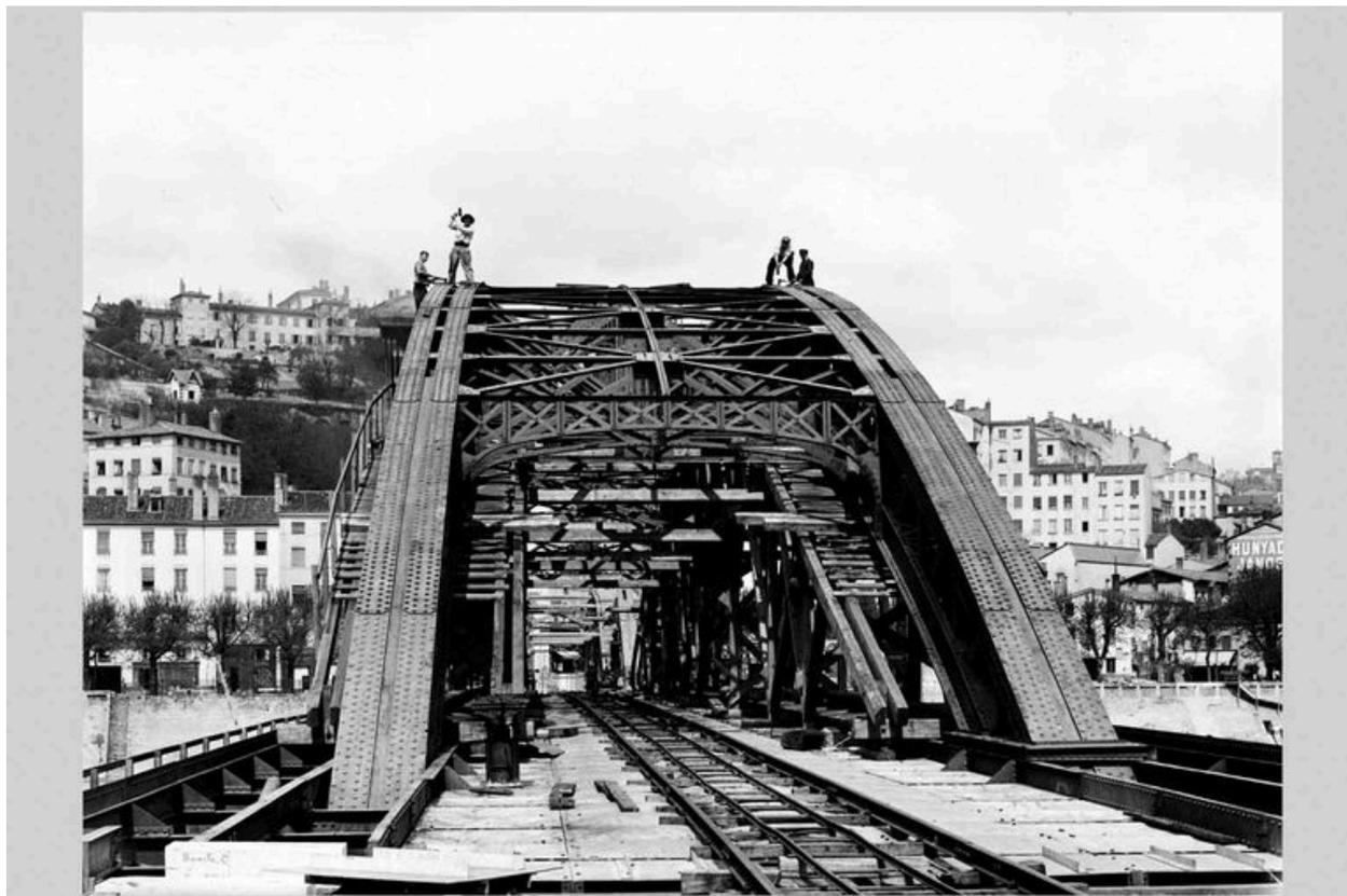
La construction du pont de la Boucle. La construction des arches supérieures. Photogr., [1903] (Arch. mun. Lyon. 15 Ph 1826)
