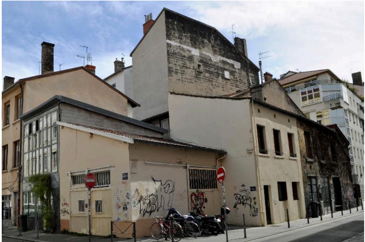
Vue de situation depuis le sud-ouest, montrant la construction en parpaings et l'inclinaison du toit à un pan
