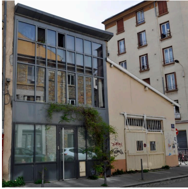
Vue de l'élévation sur rue Phot. Catherine Guégan IVR84_20176901073NUCA
