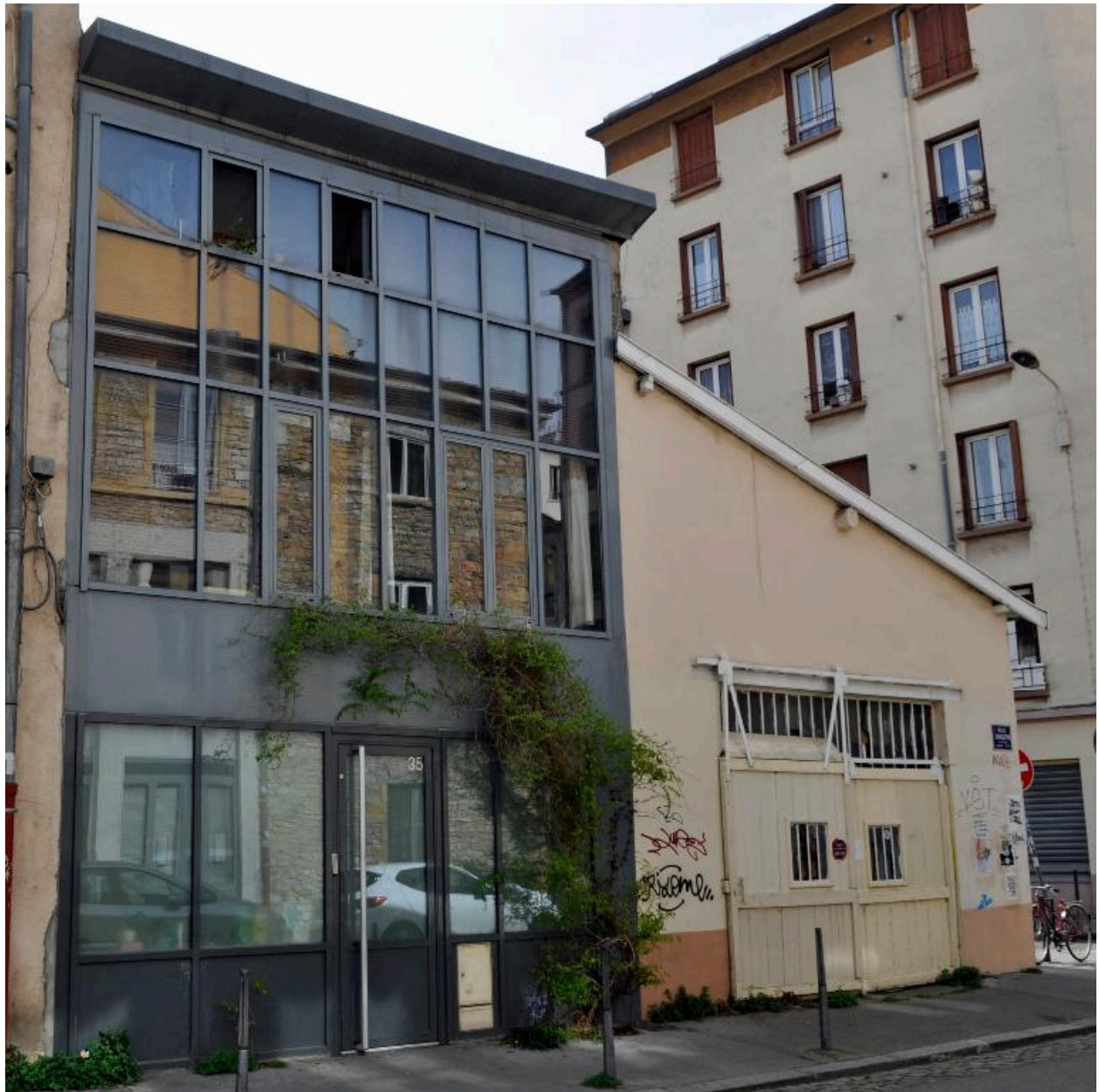
Vue de l'élévation sur rue
