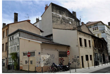
Vue de situation depuis le sud-ouest, montrant la construction en parpaings et l'inclinaison du toit à un pan Phot. Catherine Guégan IVR84_20176901074NUCA
