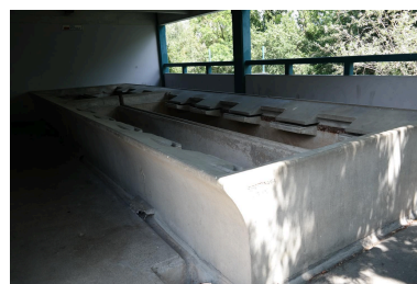
Pont de Cran, lavoir en aval Phot. Pascale Renard IVR84_20207403877NUCA
