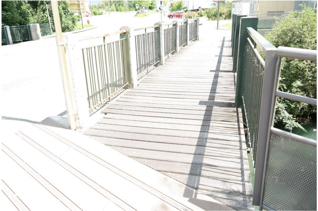
Pont de Cran, détail de la passerelle piétonne
