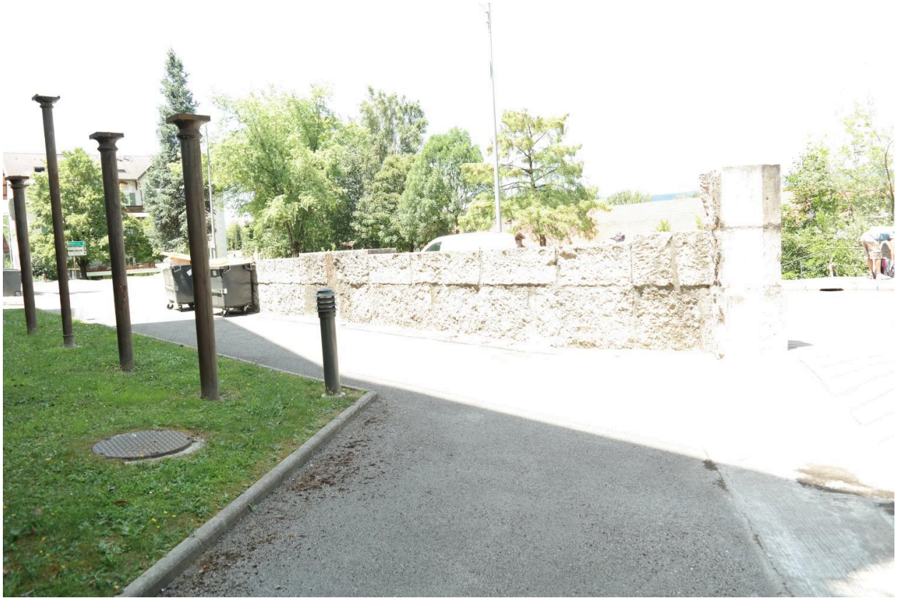
Pont de Cran, détail du vestige de mur ou de parapet
