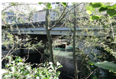
Pont de Cran, vue de la face aval Phot. Pascale Renard IVR84_20207403873NUCA
