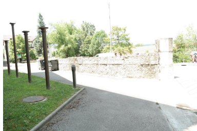
Pont de Cran, détail du vestige de mur ou de parapet Phot. Pascale Renard IVR84_20207403878NUCA
