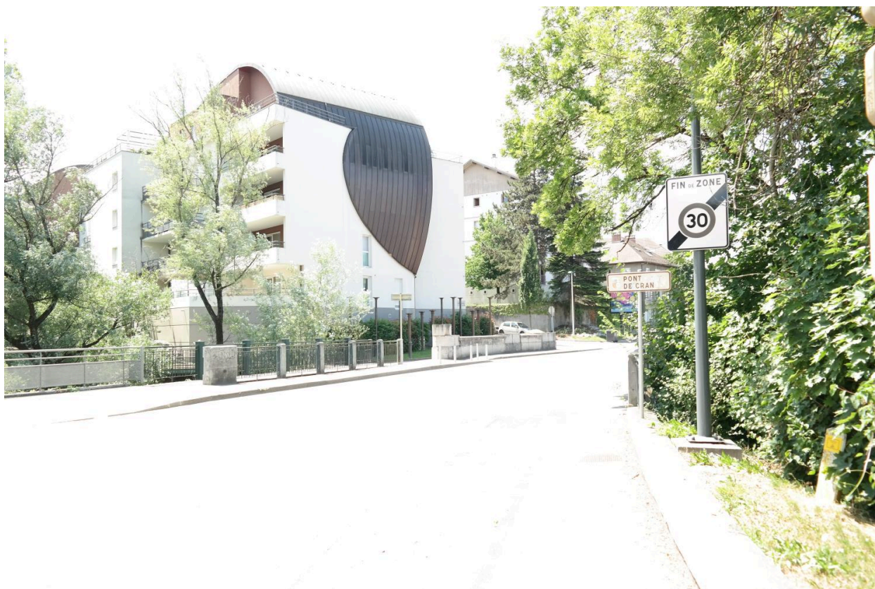
Pont de Cran, vue de la chaussée
