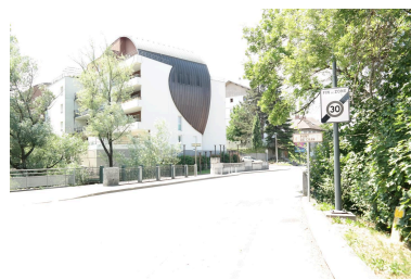
Pont de Cran, vue de la chaussée Phot. Pascale Renard IVR84_20207403874NUCA
