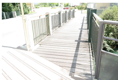
Pont de Cran, détail de la passerelle piétonne Phot. Pascale Renard IVR84_20207403875NUCA
