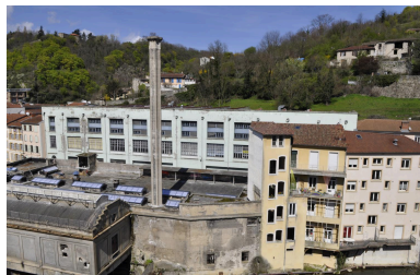
Vue d'ensemble de l'usine depuis la voie rapide Phot. Nadine Halitim-Dubois IVR84_20203800500NUCA
