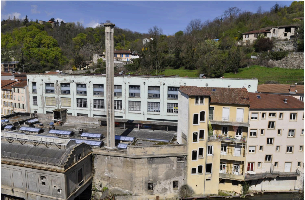
Vue d'ensemble de l'usine depuis la voie rapide
