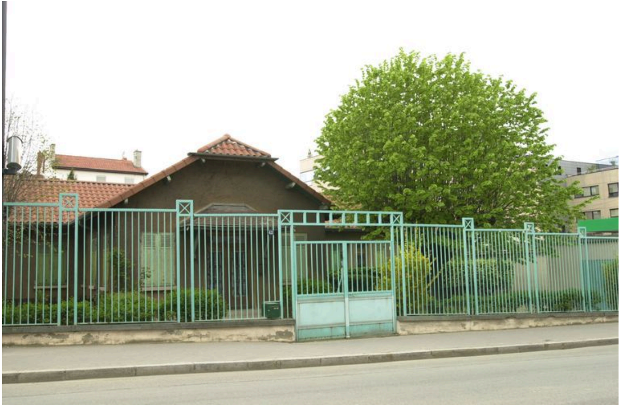
Détail de l'élévation antérieure
