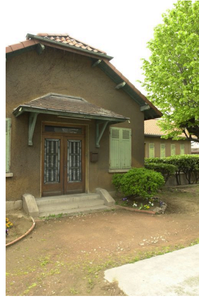
Vue partielle de l'élévation antérieure Phot. Bernard Ducouret IVR82_20046902105NUCA
