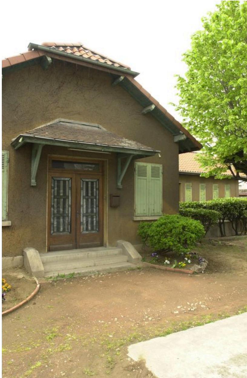
Vue partielle de l'élévation antérieure
