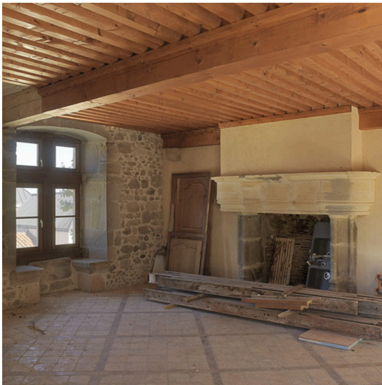
Tour des prisons au 1er étage : cheminée, fenêtre à croisées et à coussièges (15e siècle).
