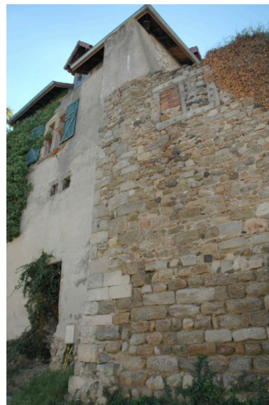
Elévation nord de la tour des Prisons Phot. Simone Hartmann-Nussbaum IVR82_20104200705NUCA
