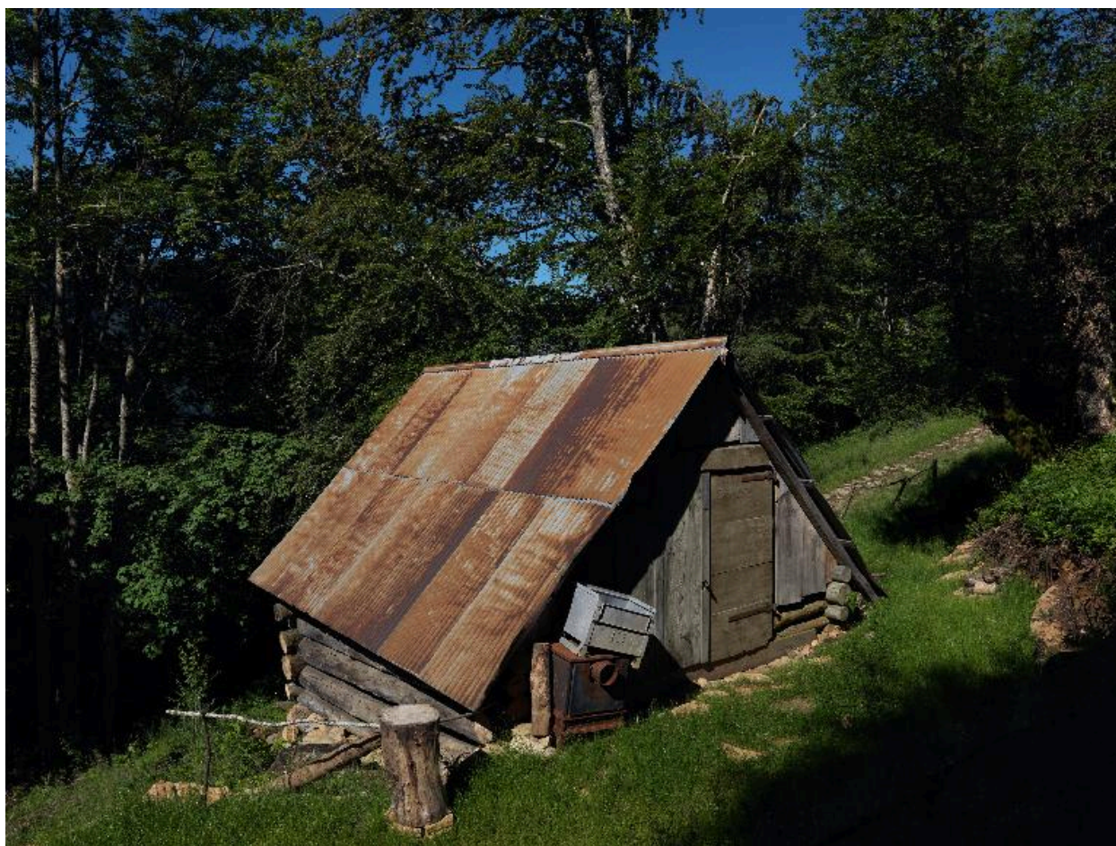
Vue d'ensemble (côté amont).
