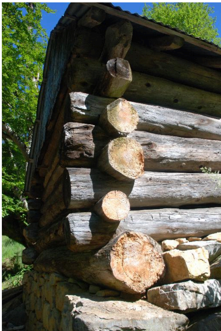
Détail d'un angle : pointes sciées récemment, marques entaillées dans un rondin.
