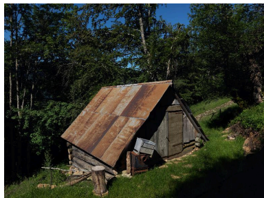
Vue d'ensemble (côté amont). Phot. Thierry Leroy IVR84_20167401572NUCA
