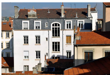
Vue générale, élévation sur cour Phot. Catherine Guégan IVR84_20176901066NUCA
