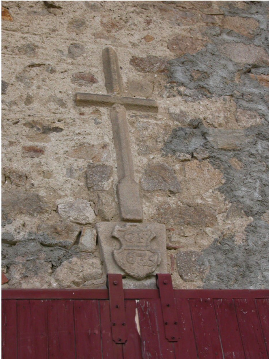
Détail de l'écusson daté 1635 et de la croisée de fenêtre remployée au-dessus.
