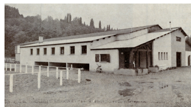
Vue de trois-quart du club-house et du manège Repro. François Fouger IVR82_20057300478NUCB
