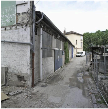
Passage le long de la façade est, vue sud Phot. Eric Dessert IVR82_20086901164NUCA
