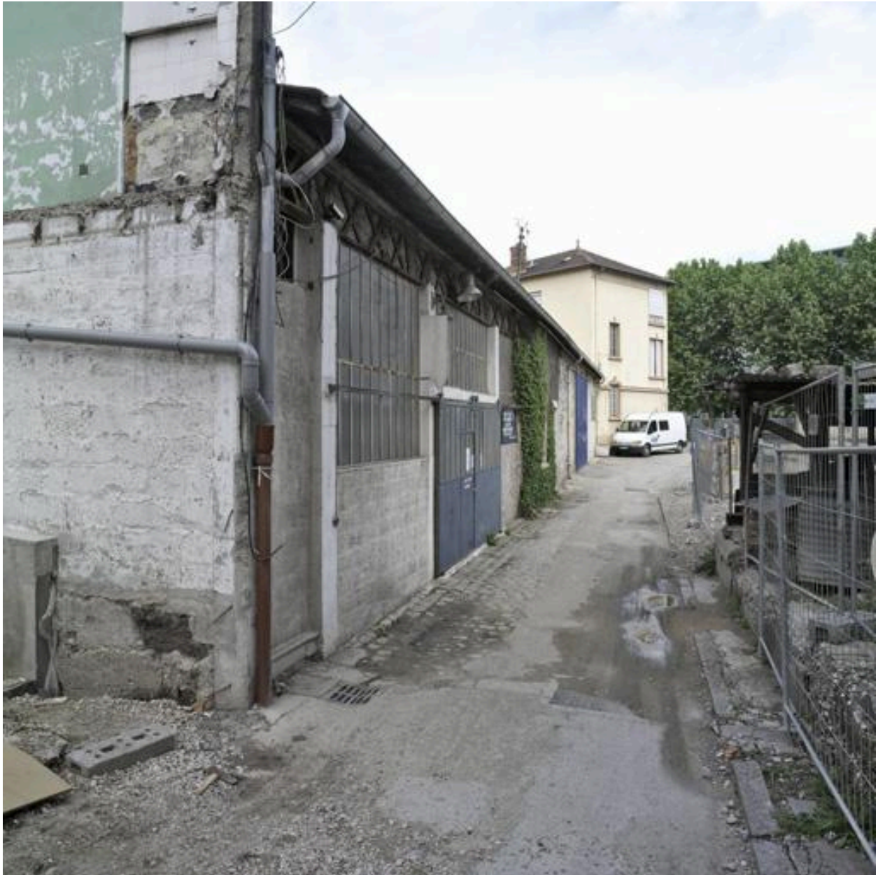
Passage le long de la façade est, vue sud
