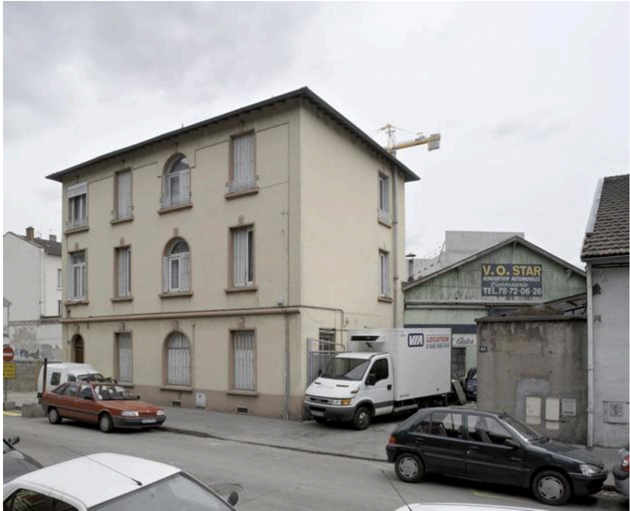
Bâtiment entrée principale
