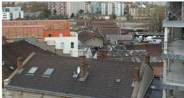
Vue zénithale est des ateliers ABC Bois Phot. Nadine Halitim-Dubois IVR82_20086900277NUCA
