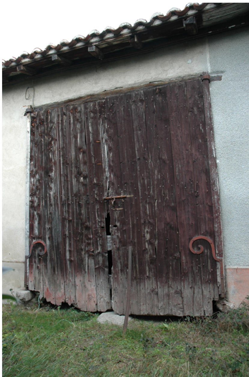
Détail d'un portail à Azieux (1986 C1 210).
