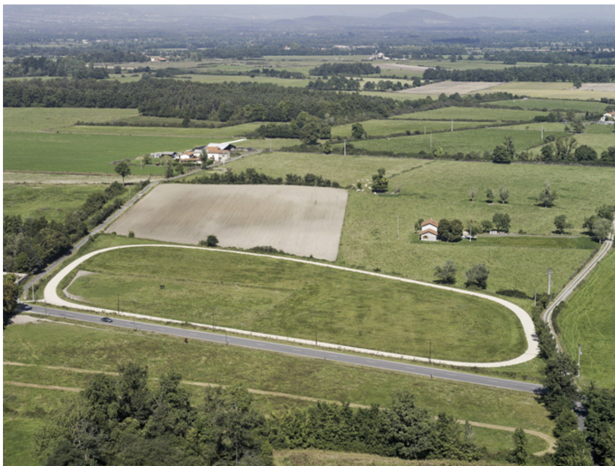
Vue aérienne d'un anneau d'entrainement pour chevaux de course (trotteurs).
