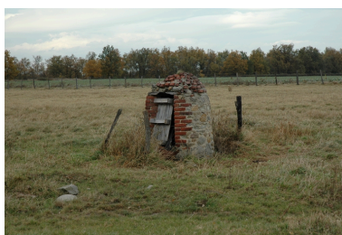
Puits commun à la Pompée (2003 ZB 7). Phot. Caroline Guibaud IVR82_20114201427NUCA
