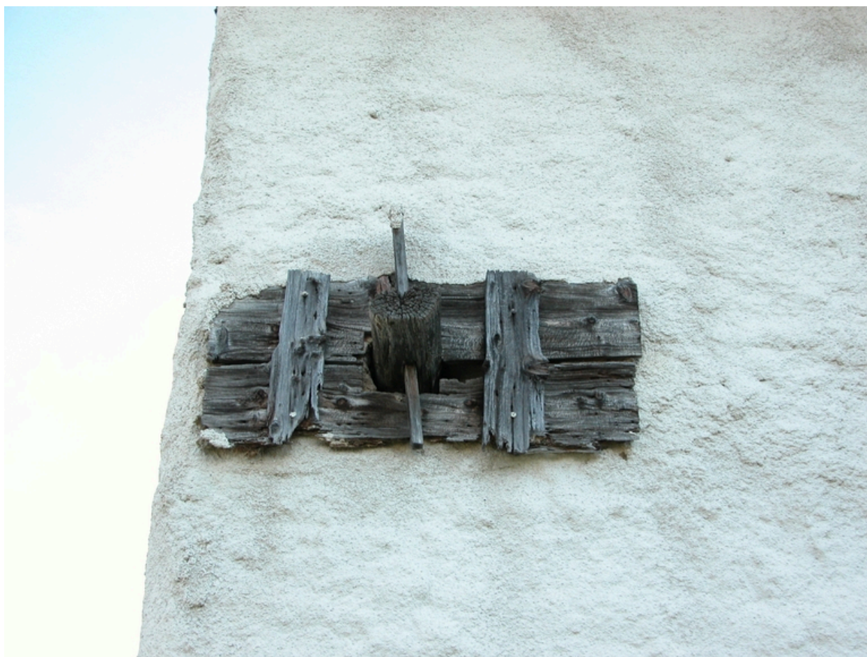
Détail de construction aux Bichaizons (2003 ZN 42) : clef en bois.
