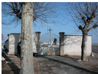
Vue du cimetière (les Baluzes, 2003 ZE 44). Phot. Caroline Guibaud IVR82_20114201432NUCA
