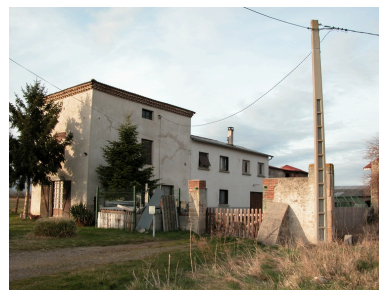
Ferme à la Vue (1986 D1 462). Phot. Caroline Guibaud IVR82_20114201421NUCA
