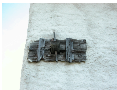
Détail de construction aux Bichaizons (2003 ZN 42) : clef en bois. Phot. Caroline Guibaud IVR82_20114201425NUCA
