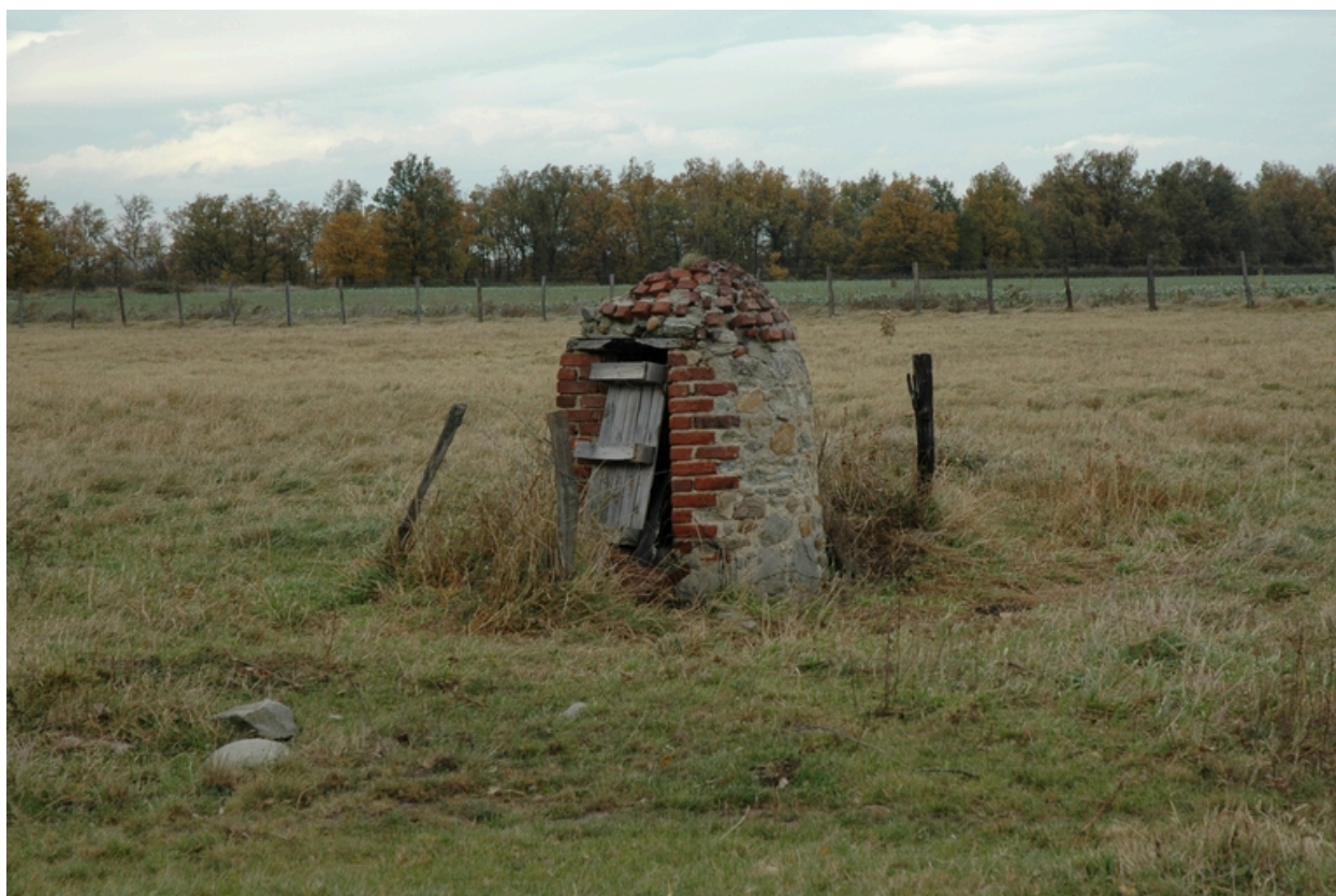
Puits commun à la Pompée (2003 ZB 7).
