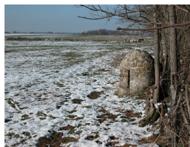
Puits aux Marais (2003 ZC 39). Phot. Caroline Guibaud IVR82_20114201428NUCA
