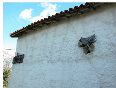
Détail de construction aux Bichaizons (2003 ZN 42) : clefs en bois. Phot. Caroline Guibaud IVR82_20114201424NUCA
