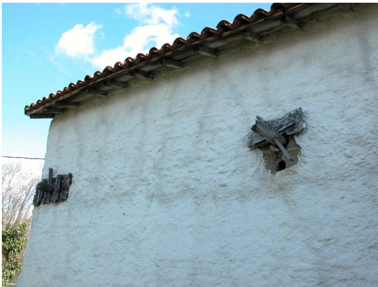
Détail de construction aux Bichaizons (2003 ZN 42) : clefs en bois.
