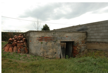
Cave isolée à Grange Neuve (1986 C1 71). Phot. Caroline Guibaud IVR82_20114201423NUCA
