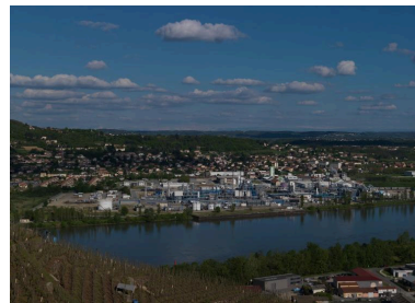
Vue d'ensemble ouest de l'usine Adisséo Phot. Thierry Leroy IVR84_20163800165NUCA
