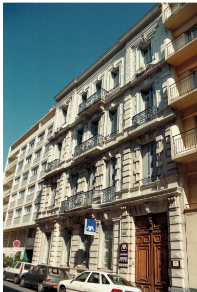
Façade principale Phot. Cendrine Sanquer IVR82_19974201849ZE
