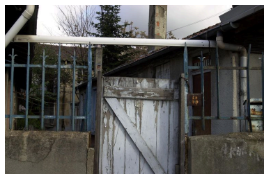
Vue partielle de la cour depuis la rue Antonin-Laborde Phot. Bernard Ducouret
