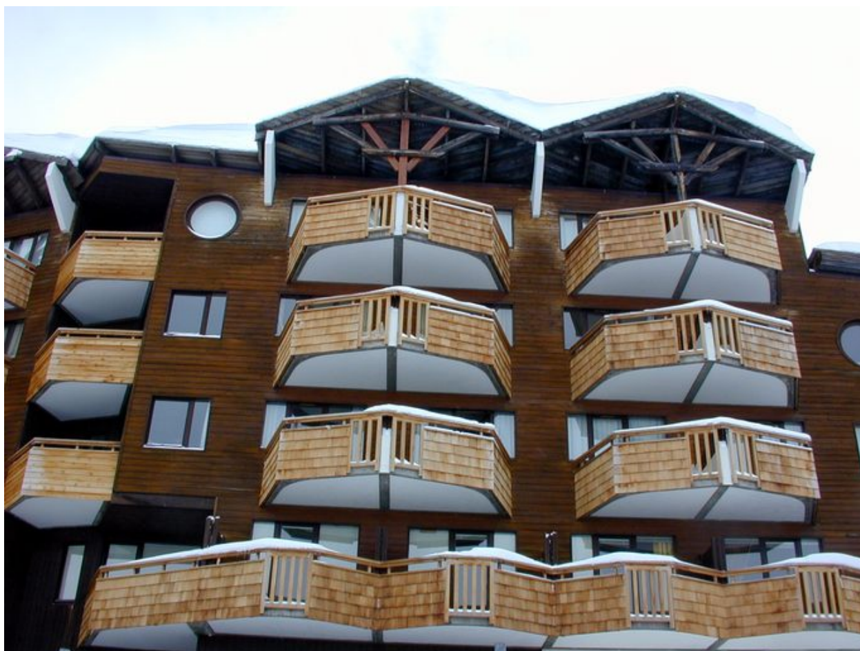
Détail des balcons de la façade aval
