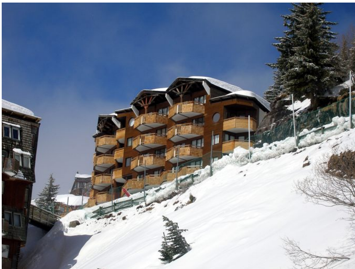
Vue depuis le sud-est
