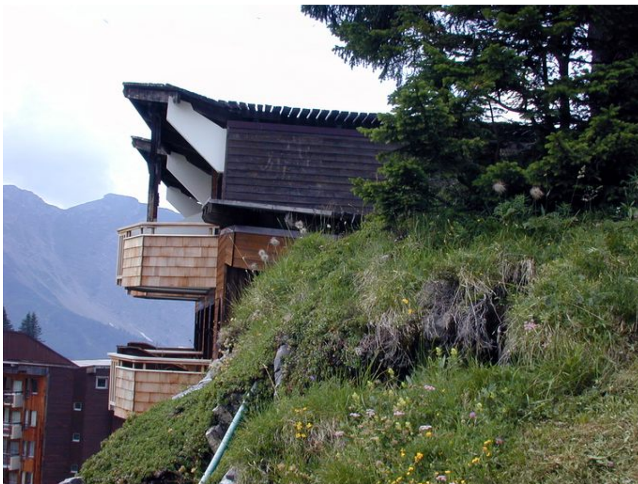
Détail du pignon est
