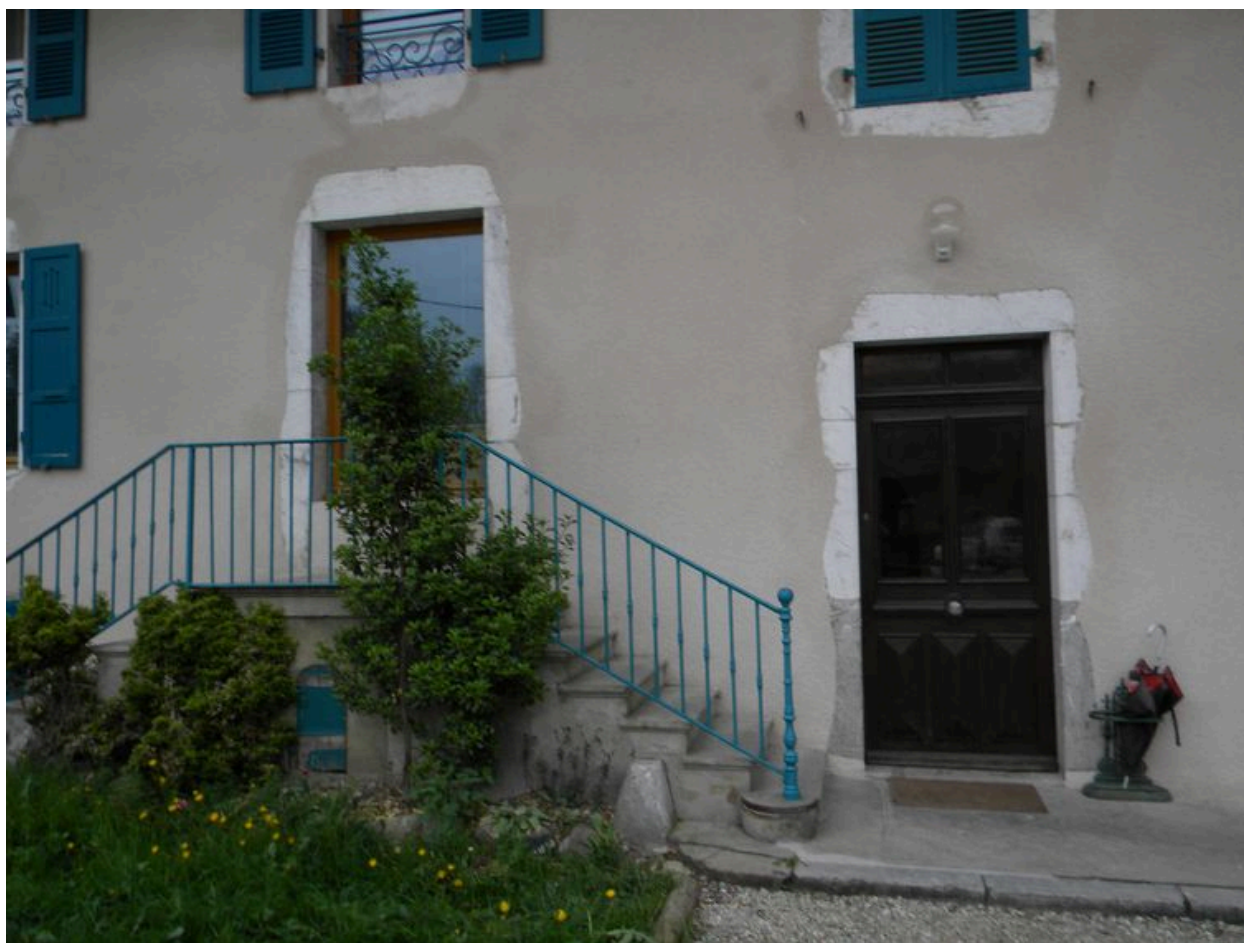
Perron et escalier à double vollée devant l'entrée principale.
