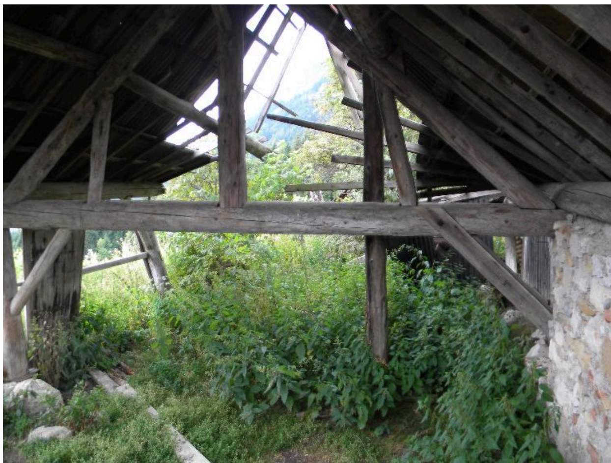
Vue des vestiges depuis l'intérieur.
