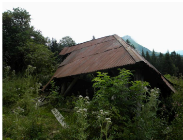
Vue de la toiture effondrée sur la partie étable à l'ouest. Phot. Jérôme Daviet IVR84_20167306782NUCA
