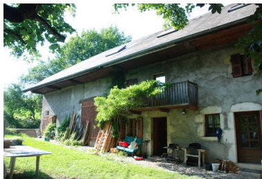
Vue d'ensemble. Phot. Thierry Monnet IVR84_20207400545NUCA
