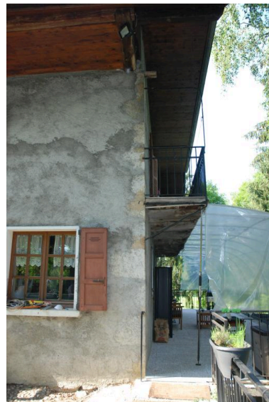
Balcon-galerie sur le mur pignon. Phot. Thierry Monnet IVR84_20207400543NUCA
