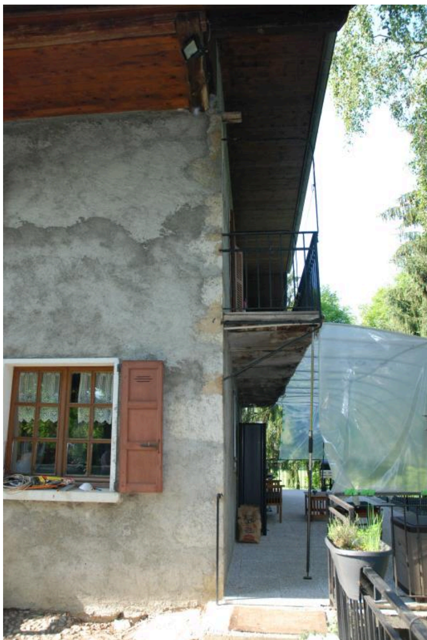
Balcon-galerie sur le mur pignon.
