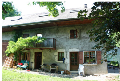
Vue d'ensemble. Phot. Thierry Monnet IVR84_20207400544NUCA
