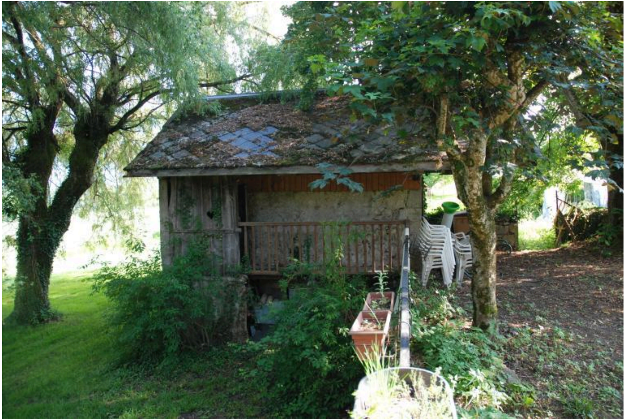
Vue latérale du four à pain.
