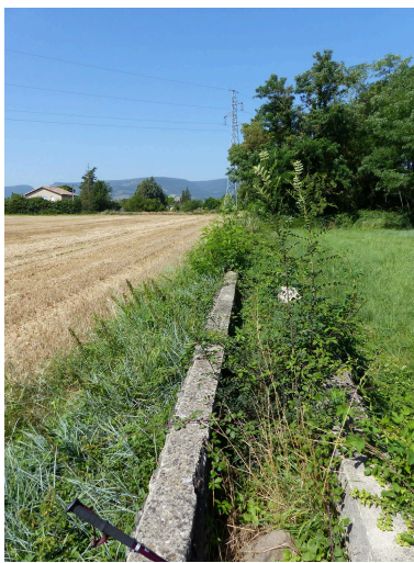
Aqueduc : vue du canal par en-dessus Phot. Nadine Halitim-Dubois IVR84_20180700075NUCA
