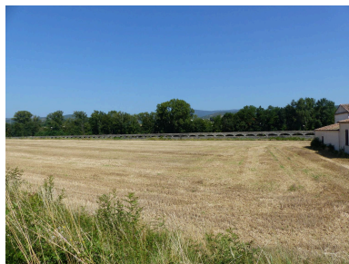
Vue générale de l'aqueduc Phot. Nadine Halitim-Dubois IVR84_20180700069NUCA
