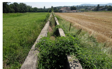
Aqueduc vue du canal par en-dessus Phot. Nadine Halitim-Dubois IVR84_20180700080NUCA
