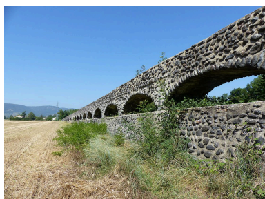
Aqueduc détail Phot. Nadine Halitim-Dubois IVR84_20180700070NUCA
