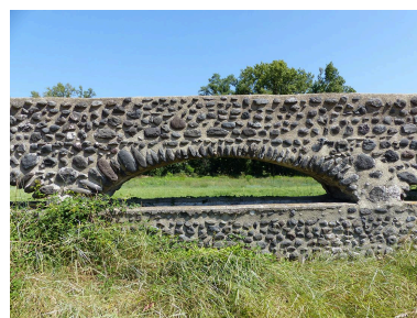
Aqueduc : détail arche maçonnée en galets Phot. Nadine Halitim-Dubois IVR84_20180700078NUCA
