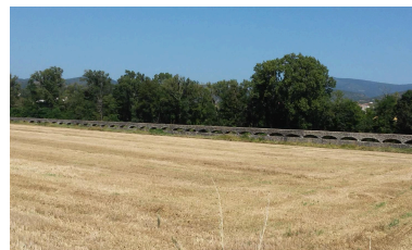
Aqueduc : vue d'ensemble dans un grand paysage Phot. Nadine Halitim-Dubois IVR84_20180700079NUCA
