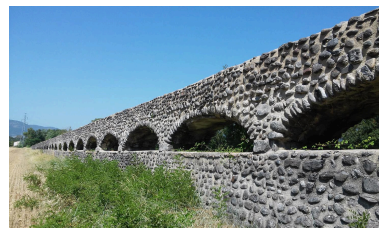
Aqueduc vue ouest Phot. Nadine Halitim-Dubois IVR84_20180700066NUCA
