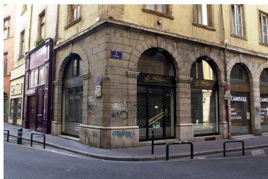
Façade nord sur la rue Chavanne, rez-de-chaussée Phot. Bernard Ducouret IVR82_20036904506NUCA
