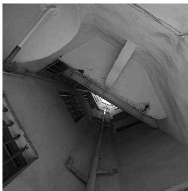
Cour, vue par-dessous depuis la coursière du 1er étage Phot. Eric Dessert IVR82_20056901718NUC
