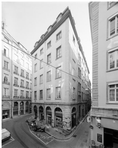
Vue générale de la façade sur la rue Longue et de la façade ouest sur la rue Chavanne Phot. Didier Gourbin IVR82_20056902655V
