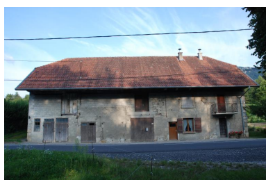
2015 A7 1235, Chez Thomé, ferme. Vue d'ensemble de face. Phot. Thierry Monnet IVR84_20207401831NUCA
