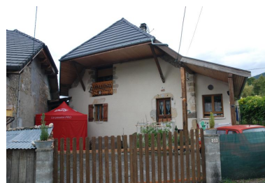
2015 A2 138, la Chiésaz-Nord, ferme. Vue partielle de la ferme. Phot. Thierry Monnet IVR84_20207401737NUCA
