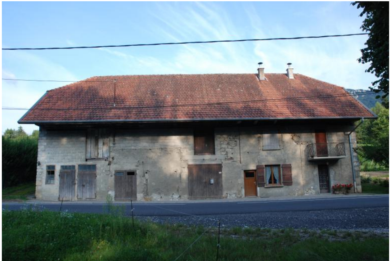
2015 A7 1235, Chez Thomé, ferme. Vue d'ensemble de face.
