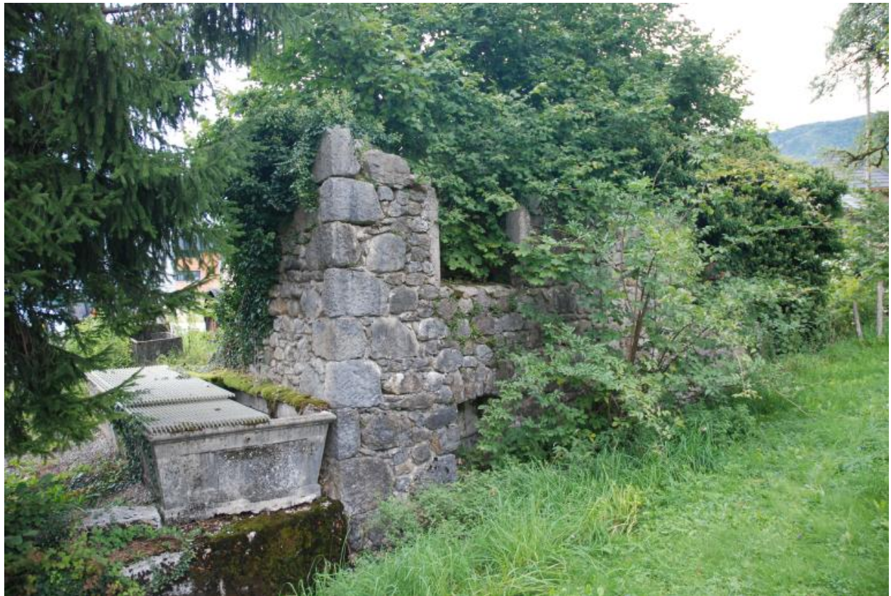
2015 A2 141, la Chiésaz-Nord, scierie. Vue partielle des ruines de la scierie
