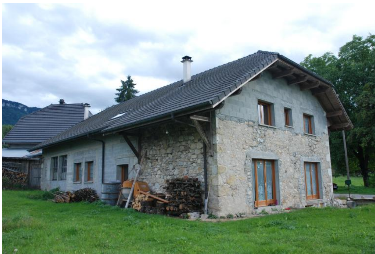
2026 A2 133 à 135, 1457, la Chiésaz-Nord, ferme. Vue générale de trois-quarts arrière de la ferme
