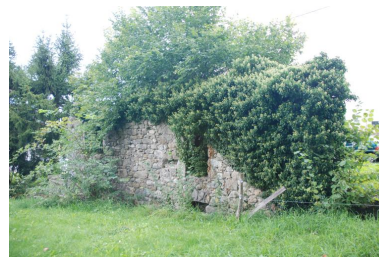
2015 A2 141, la Chiésaz-Nord, scierie. Vue partielle des ruines de la scierie Phot. Thierry Monnet IVR84_20207401740NUCA
