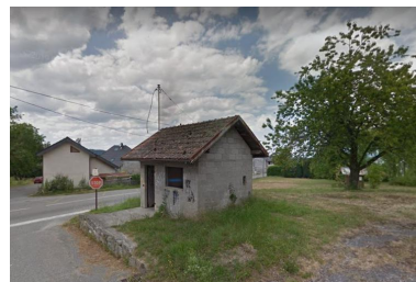
2015 A3 1035, les Cretes, poste à lait. Vue d'ensemble Phot. Thierry Monnet IVR84_20207401773NUCA
