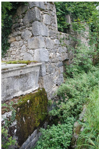
2015 A2 141, la Chiésaz-Nord, scierie. Vue partielle des ruines de la scierie Phot. Thierry Monnet IVR84_20207401739NUCA
