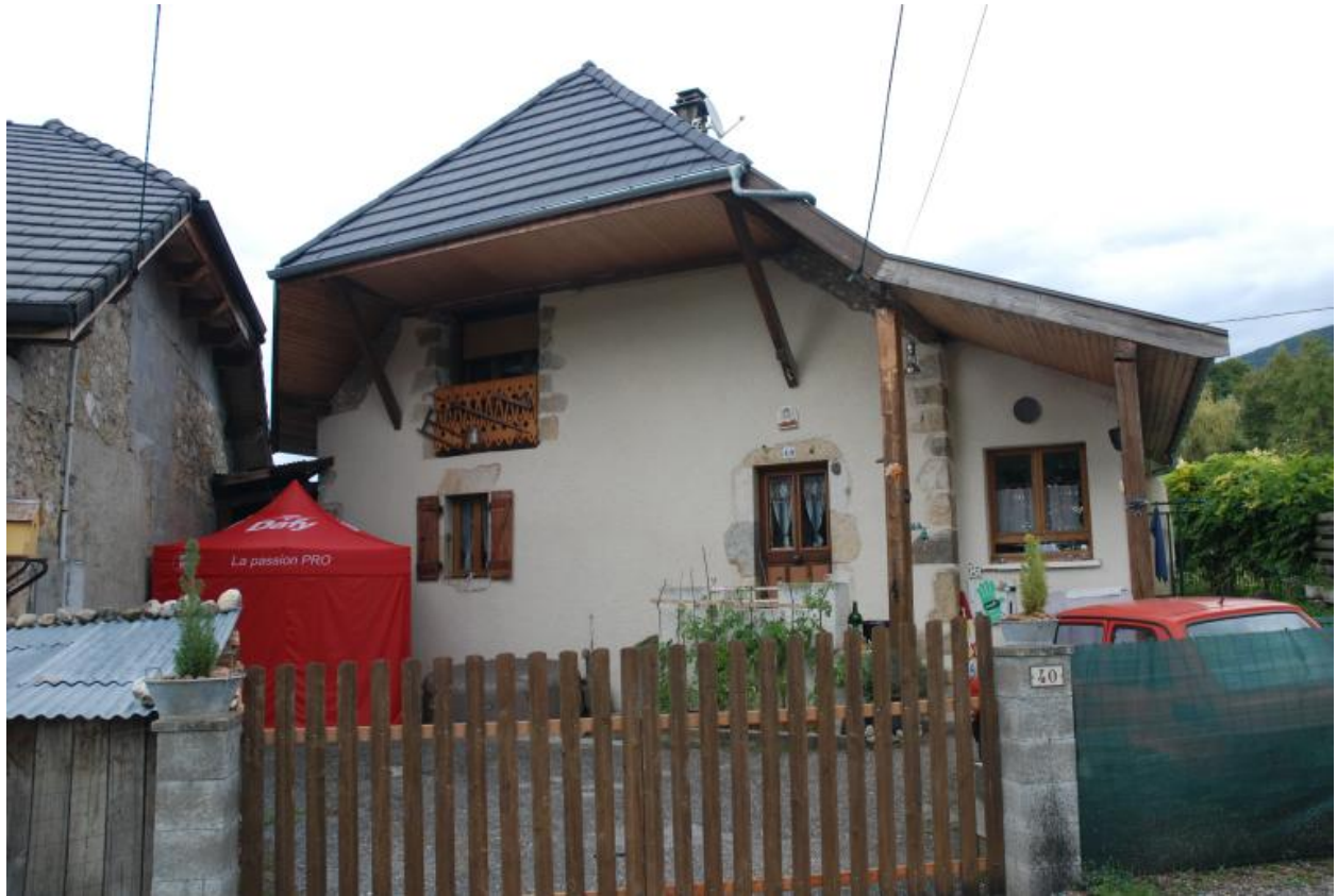
2015 A2 138, la Chiésaz-Nord, ferme. Vue partielle de la ferme.
