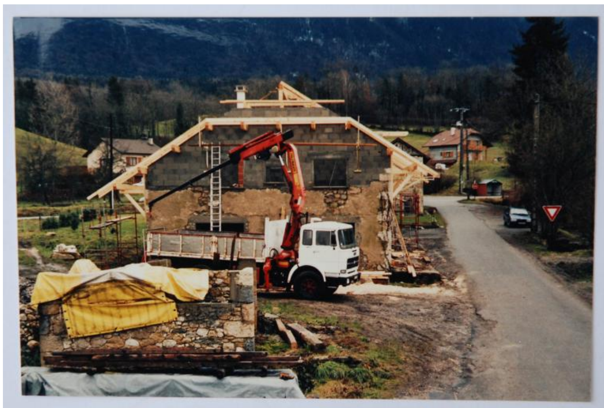
2021 A2 133 à 135, 1457, la Chiésaz-Nord, ferme. Photographie ancienne durant la rénovation.
