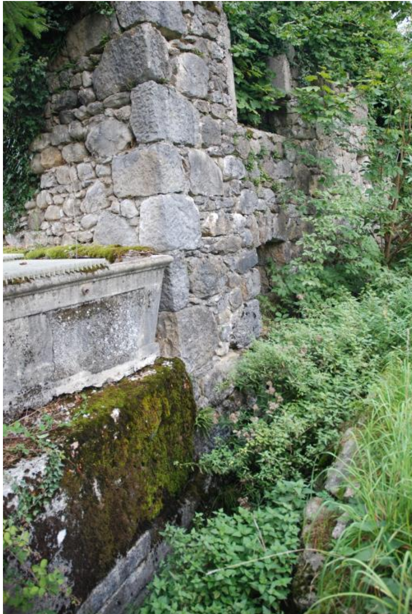
2015 A2 141, la Chiésaz-Nord, scierie. Vue partielle des ruines de la scierie
