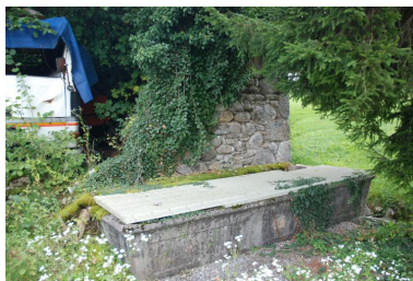
2018 A2 141, la Chiésaz- Nord, scierie. Vue d'ensemble du bassin daté 1930. Phot. Thierry Monnet IVR84_20207401748NUCA
