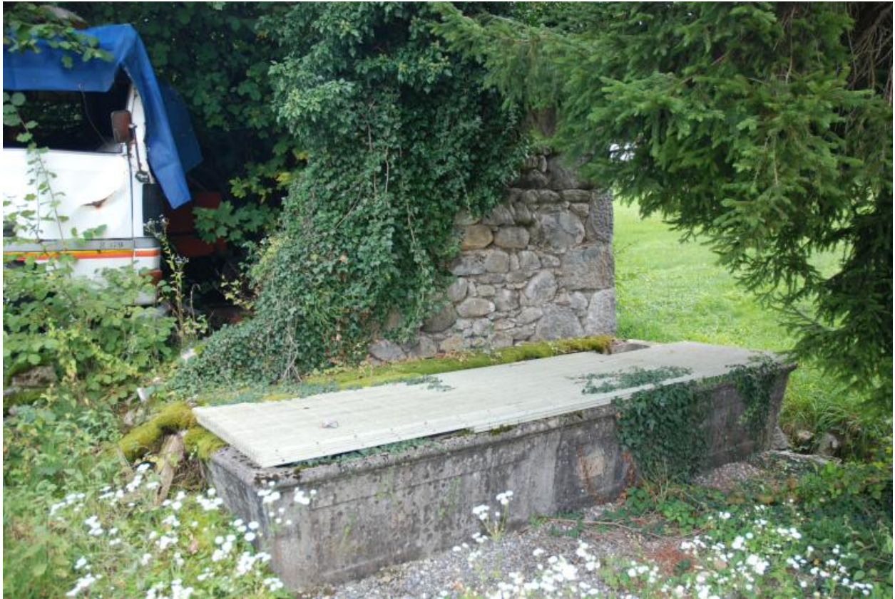
2018 A2 141, la Chiésaz-Nord, scierie. Vue d'ensemble du bassin daté 1930.
