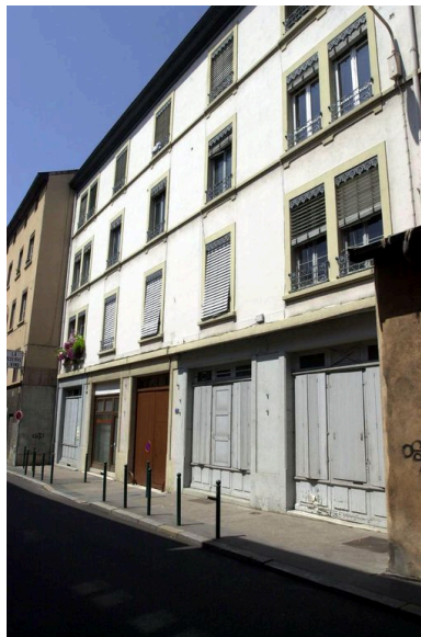
Elévation antérieure Phot. François Blanchetière IVR82_20016902241NUCA
