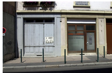
Détail de la devanture de boutique située à gauche de l'entrée de l'immeuble Phot. François Blanchetière IVR82_20016902243NUCA
