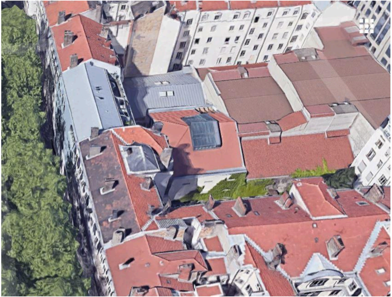
Papeterie Alibaux (vue Google) ensemble des ateliers sur cour.
