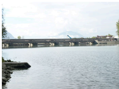
Vue générale, face amont (depuis la rive gauche) Phot. B. Decrock IVR82_20107300029NUCA
