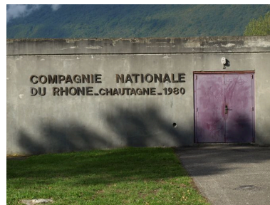
Façade, vue partielle : date portée Phot. B. Decrock IVR82_20107300031NUCA
