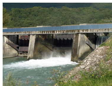
Passe, vue partielle face aval (depuis la rive gauche) Phot. B. Decrock IVR82_20107300028NUCA
