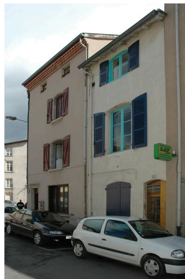
Vue générale, maison au 1er plan. Phot. Simone Hartmann-Nussbaum IVR82_20124202688NUCA
