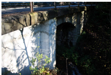
Pont du Martelet, face aval Phot. Benoît Huraut IVR84_20207401285NUCA
