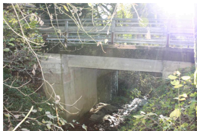
Pont du Martelet, face amont IVR84_20197401285NUCA
