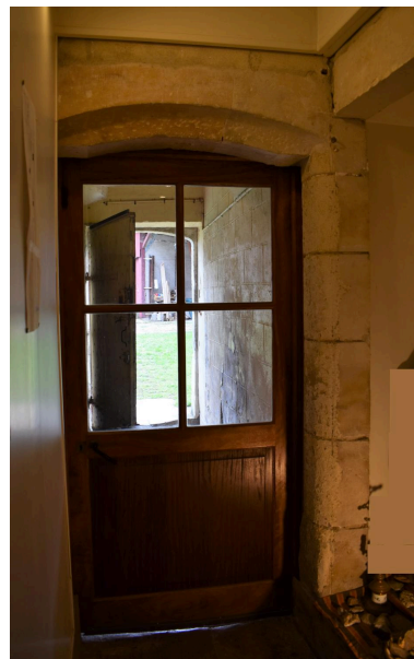
Portes à encadrements appareillés de pierres de taille et linteaux chanfreinés dans le couloir d'entrée de la tour d'escalier. Phot. Maryse Durin-Tercelin IVR84_20250300547NUCA
