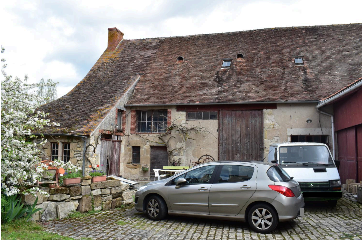
Vue générale des communs.
