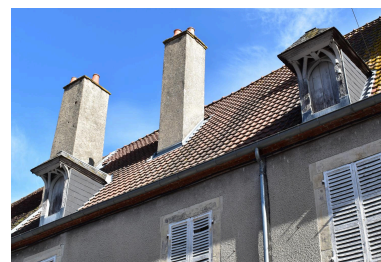
Vue des lucarnes charpentées, rue d'Allier. Phot. Maryse Durin-Tercelin IVR84_20260300067NUCA
