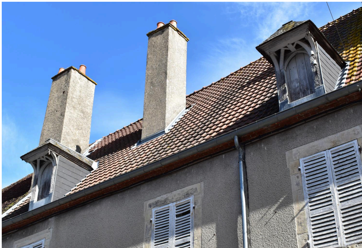
Vue des lucarnes charpentées, rue d'Allier.
