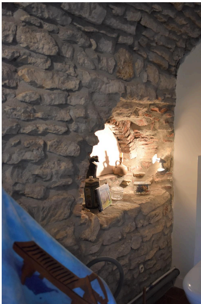
Ancienne gueule d'un four à pain, rez-de-chaussée.
