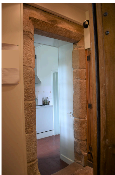
Porte à encadrement de pierre de taille et linteau chanfreiné, rez-de-chaussée. Phot. Maryse Durin-Tercelin IVR84_20250300549NUCA
