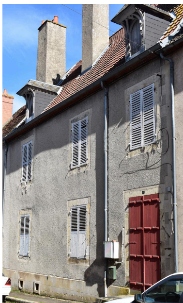
Vue de la façade, rue d'Allier. Phot. Maryse Durin-Tercelin IVR84_20260300066NUCA
