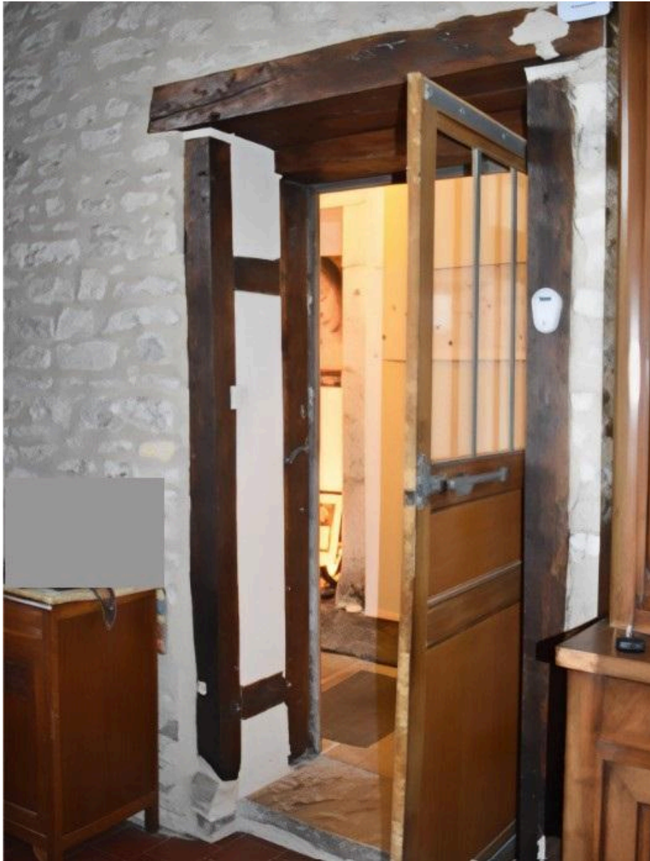
Encadrement de porte charpenté, porte d'accès à l'ancienne cuisine, rez-de-chaussée.
