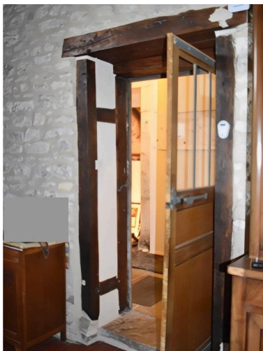
Encadrement de porte charpenté, porte d'accès à l'ancienne cuisine, rez-de-chaussée. Phot. Maryse Durin-Tercelin IVR84_20250300552NUC4A
