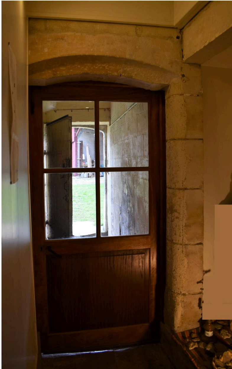
Portes à encadrements appareillés de pierres de taille et linteaux chanfreinés dans le couloir d'entrée de la tour d'escalier.
