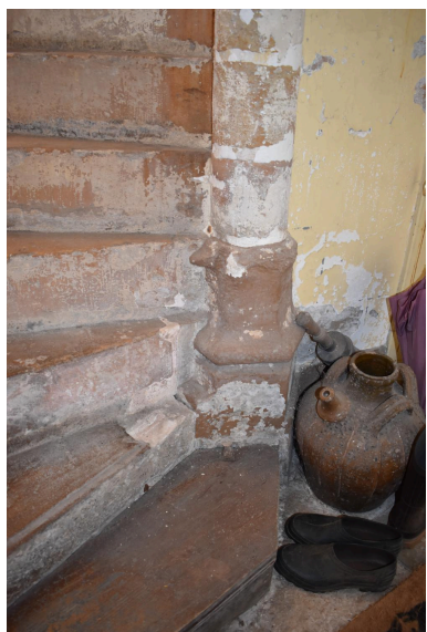
Vue de détail du noyau de l'escalier en vis, à base moulurée. Phot. Maryse Durin-Tercelin IVR84_20250300554NUC4A
