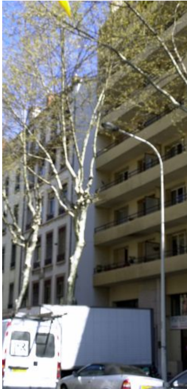
Détail de la rupture d'alignement entre le 73 et le 71 cours Charlemagne
