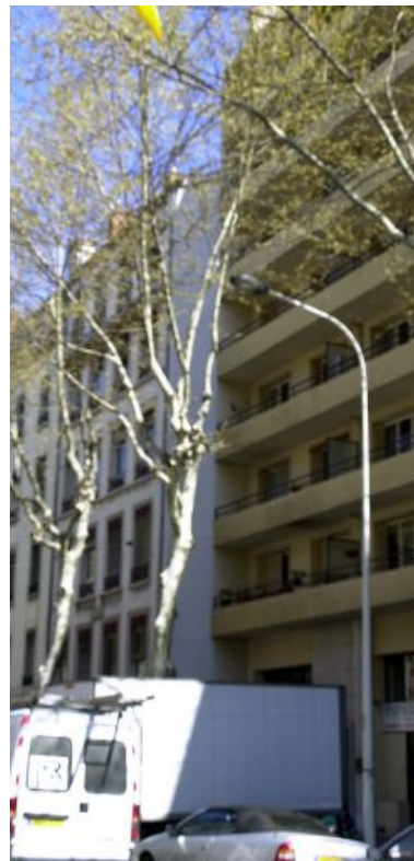
Détail de la rupture d'alignement entre le 73 et le 71 cours Charlemagne Phot. Maryannick Chalabi IVR82_20036900367NUCA
