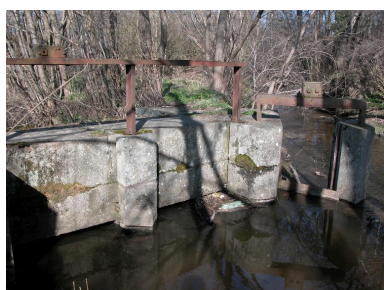
Vue partielle amont de la prise d'eau avec vanne, à droite, de trop plein. Phot. Thierry Monnet IVR82_20144200188NUCA
