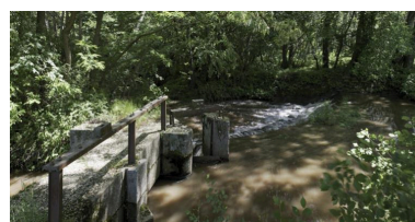
Vue d'ensemble amont de la prise d'eau en pierre de taille.
