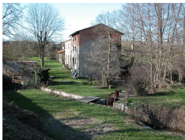
Vue d'ensemble du moulin dans son site. Phot. Thierry Monnet IVR82_20144200302NUCA
