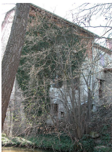
Vue partielle arrière du moulin. Phot. Thierry Monnet IVR82_20144200305NUCA
