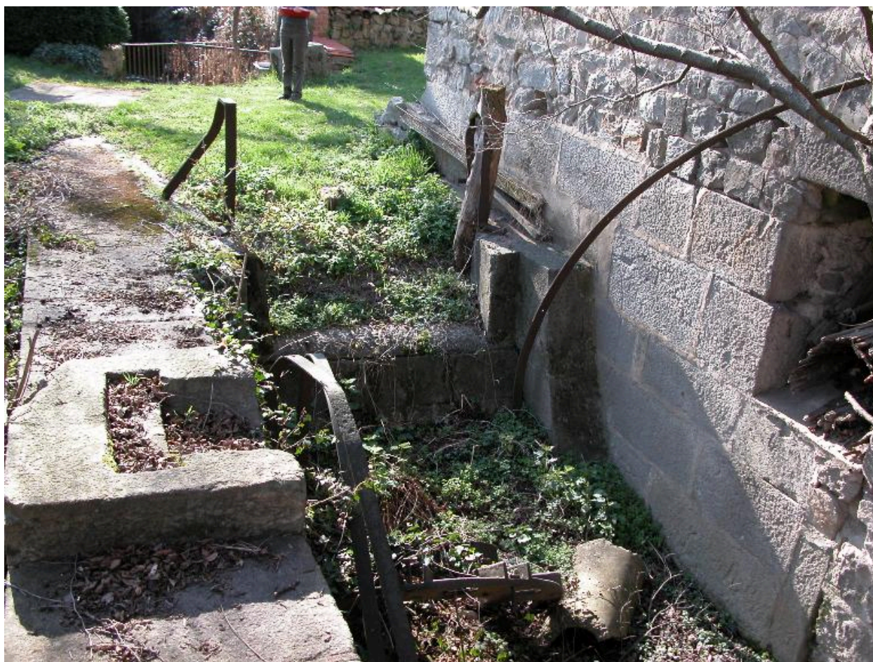
Conduit d'amenée de l'eau du bief sur le lieu où se trouvait la roue à aube du moulin.
