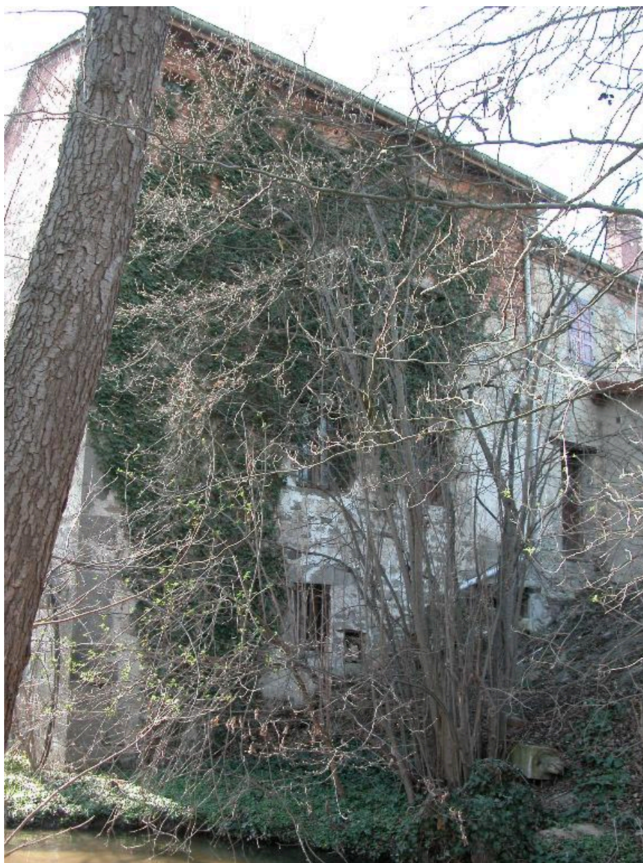
Vue partielle arrière du moulin.
