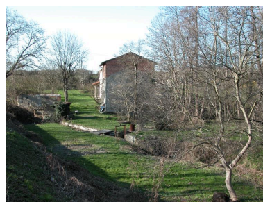
Vue d'ensemble du site du Moulin. Phot. Thierry Monnet IVR82_20144200192NUCA
