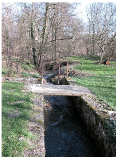
Le trop plein de l'eau du bief est conduit jusqu'à la rivière de la Mare. Phot. Thierry Monnet IVR82_20144200197NUCA
