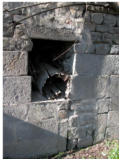
Détail de l'axe en bois de l'ancienne roue à aube du moulin. Phot. Thierry Monnet IVR82_20144200195NUCA
