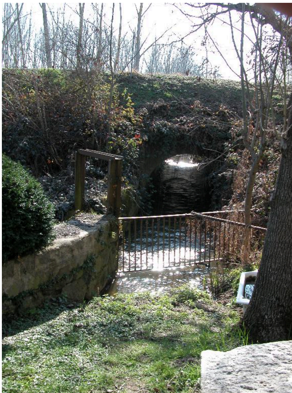
Arrivée du bief sur le site du moulin après être passé sous la route de Saint-Galmier.
