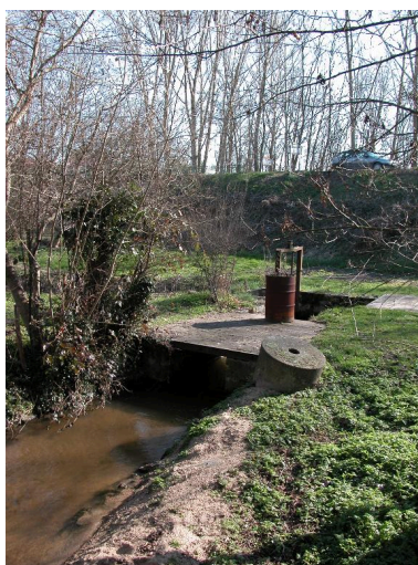
Partie du bief qui n'est pas conduit jusqu'à la roue à aube du moulin. Phot. Thierry Monnet
