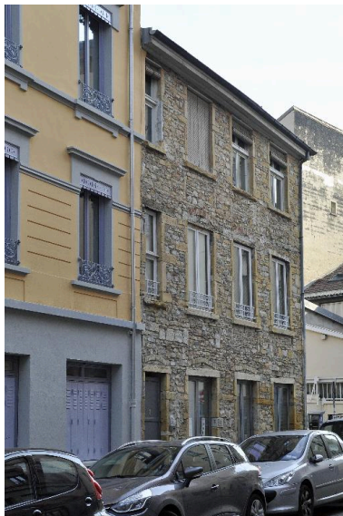
Bâtiment d'angle, élévation principale rue de la Thibaudière Phot. Magali Delavenne IVR84_20166902257NUCA
