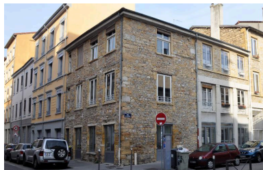
Vue générale depuis l'est Phot. Magali Delavenne IVR84_20166902254NUCA
