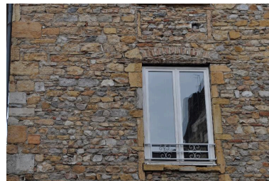
Bâtiment d'angle, détail d'une fenêtre Phot. Magali Delavenne IVR84_20166902258NUCA
