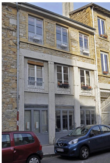
Bâtiment nord, élévation sur la rue Chalopin Phot. Magali Delavenne IVR84_20166902255NUCA
